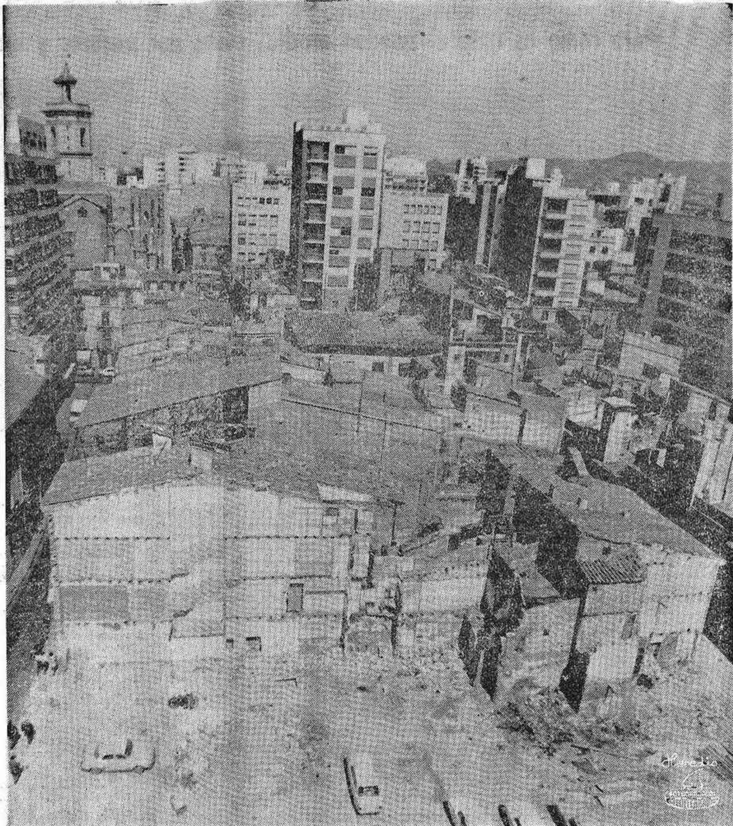
Van derribándose los edificios que dejarán libre el solar de la Plaza de enlace de la Avenida Cernuda y Velasco y la calle Mayor. Muy pronto quedará el vacío ante la que debía ser fachada de la Iglesia Mayor, cuya realización habrá de decidirse o abandonarse
