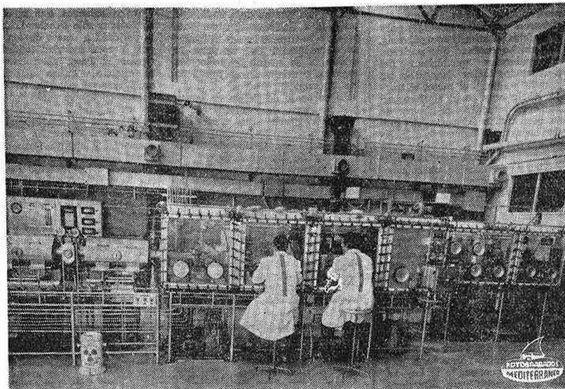
Caja de guantes de la nave de fabricación de carburo de uranio. — (Foto Pyresa).
