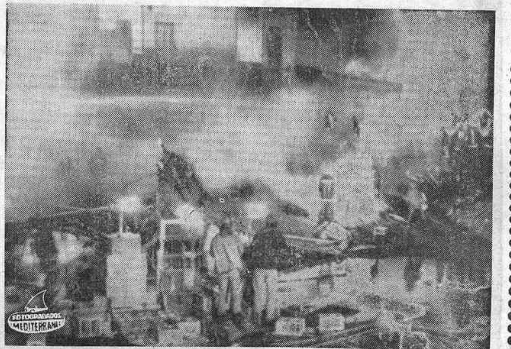
LAKE CITY (Minnesota) EE. UU.— Equipos de socorros, procedentes de seis localidades vecinas, acudieron para prestar auxilios y rescatar a las quince víctimas, sepultadas en las escombros de unas casas destruidas por una explosión de gas. Parece que hay dos muertos entre los sepultados. — (Telefoto CIFRA GRAFICA-UPI).
