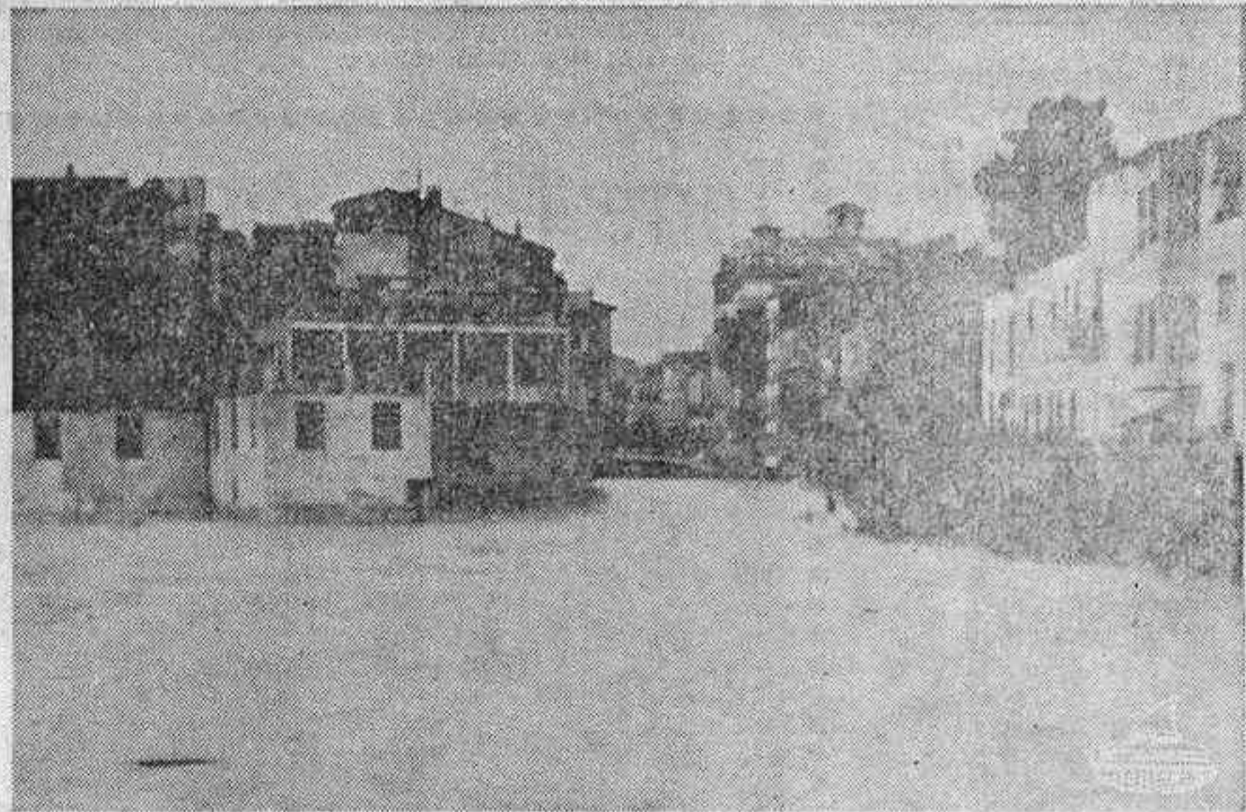
ORIHUELA (Alicante).— Las abundantes lluvias caídas en estos días han provocado numerosas inundaciones en esta localidad, como puede verse en la foto. Varios edificios han tenido que ser evacuados.— (Telefoto Cifra Gráfica).
