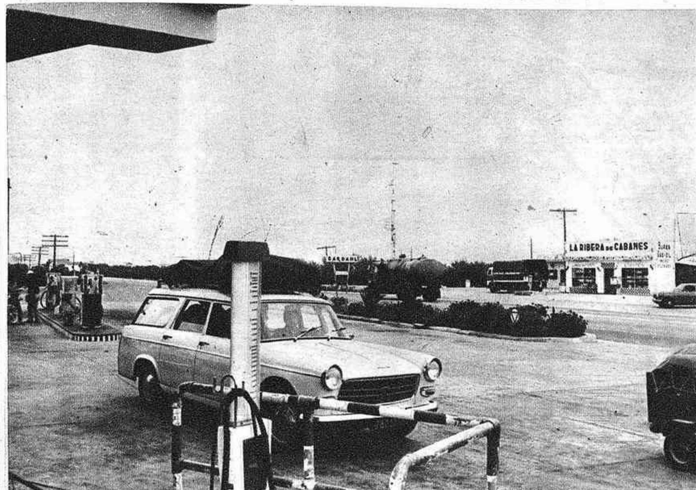
Y un poste de Gasolina Super Extra 98
