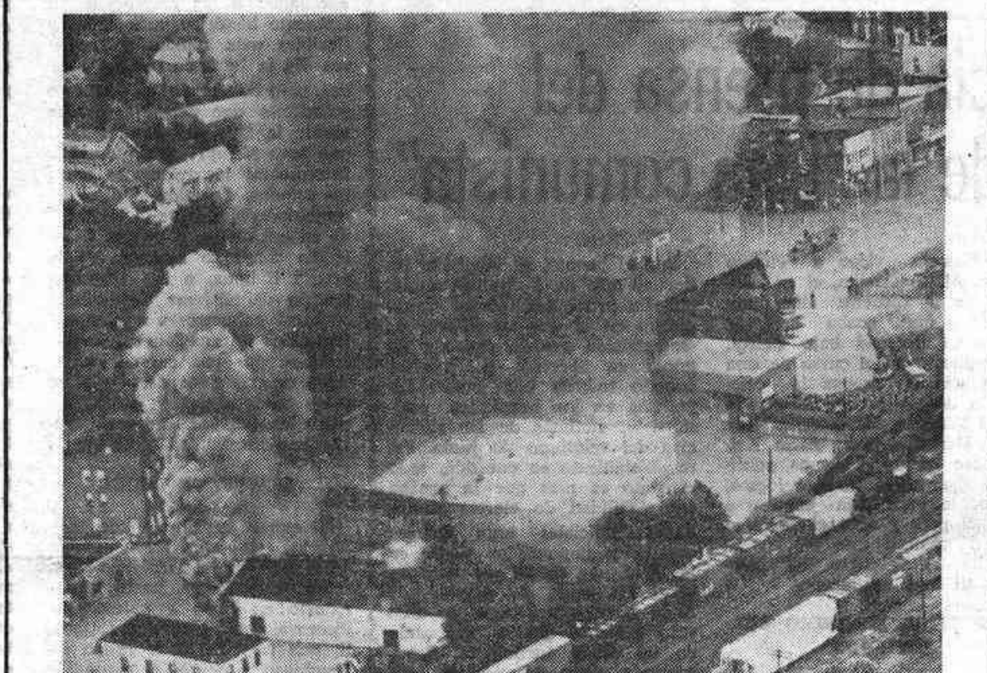
BOUND BROOK (Nueva Jersey).— El humo asciende de un edificio incendiado, mientras que un coche de bomberos no puede llegar hasta él a consecuencia de estar las calles inundadas, después de grandes lluvias, que han hecho desbordarse a los afluentes del río Raritan. Se ha declarado el estado de emergencia en siete comunidades inundadas y ha habido cuatro muertos
