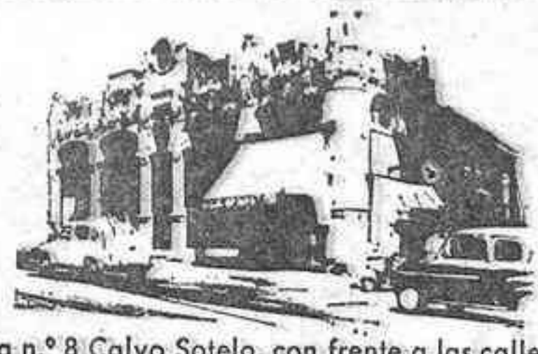
Casa n.º 8 Calvo Sotelo, con frente a las calles Misericordia y Sombrereros. Pendiente de demolición para inmediata construcción de un edificio moderno. VIGO
