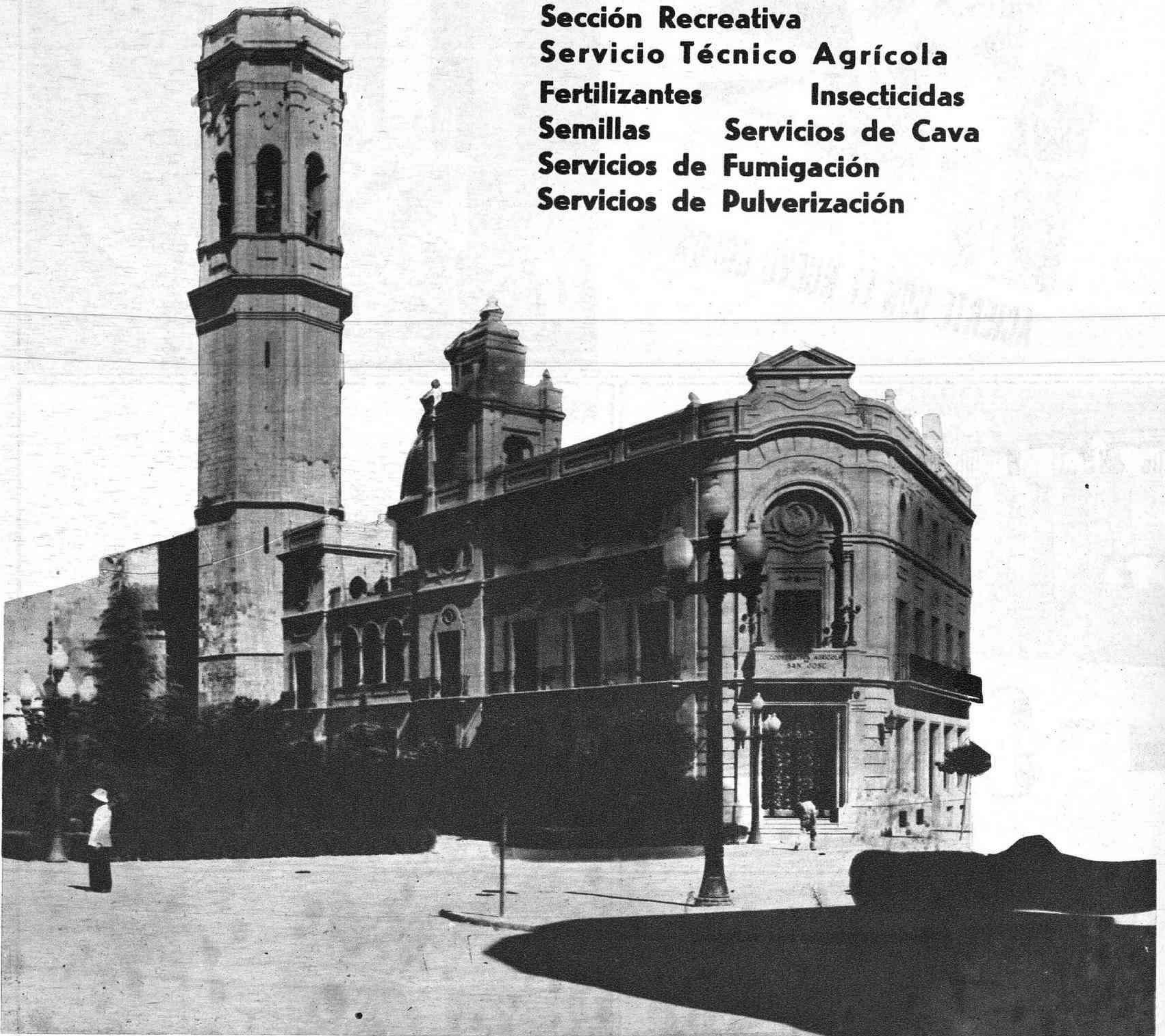
Edificio propiedad de la Cooperativa de Crédito, Caja Rural "San José".
