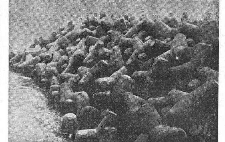
VANDELLOS (Tarragona). — Una nota curiosa en la construcción de la central nuclear de Vandellós, que ha sido puesta en marcha es el «rompeolas», que se ha fabricado a base de figuras geométricas de cemento armado. — (Foto CIFRA GRAFICA)
