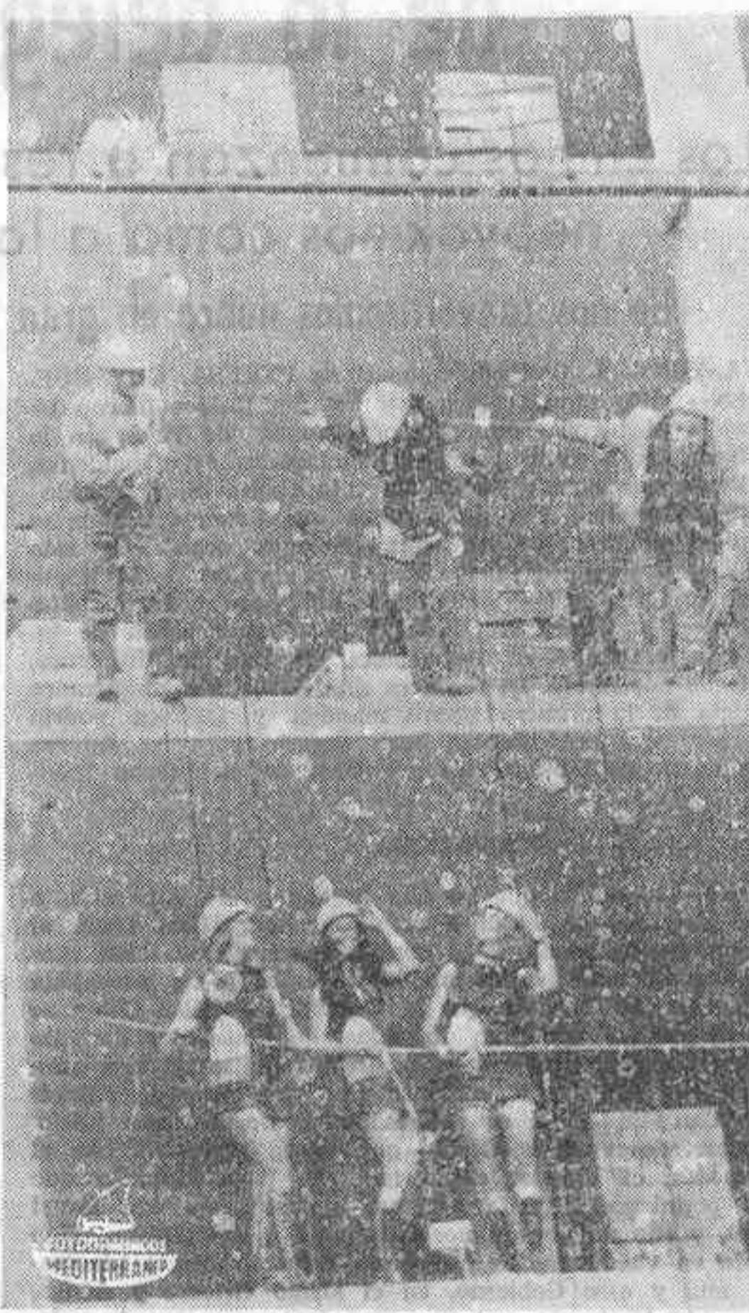
CHICAGO. — Obreros de la construcción en un cuarto piso de un nuevo edificio, se asoman peligrosamente para observar a tres jóvenes modelos que exhiben un nuevo tipo de «mini-vestido» y «mini-pantalón» en el piso inferior. Las modelos, Donna Pancamo, Mary Roddel y Diana Romas, de izquierda a derecha, escalaron el edificio por pasarelas y pasaron por andamios para mostrar su nueva indumentaria. — (Telefoto CIFRA GRAFICA-UPI)
