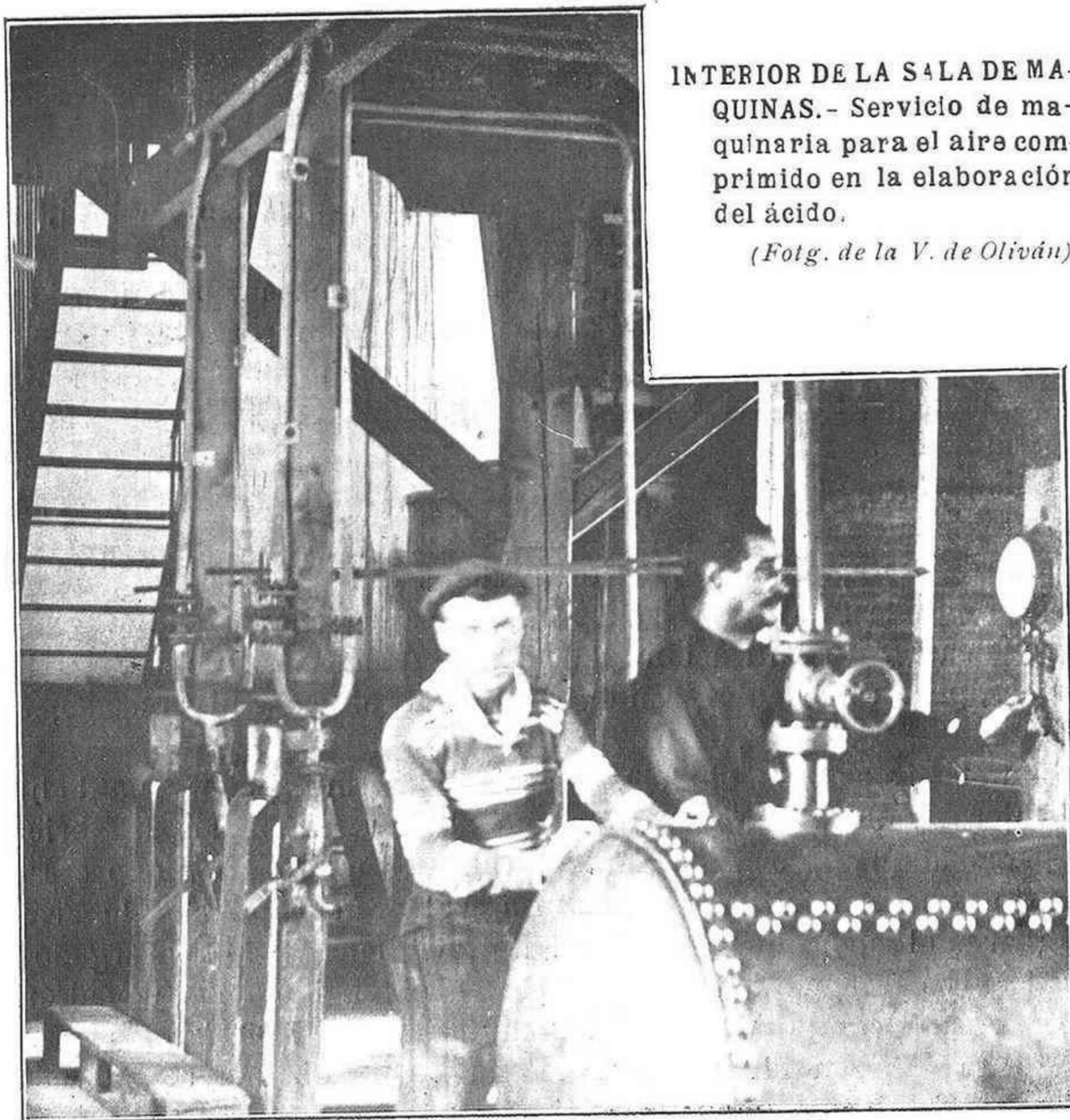
INTERIOR DE LA SALA DE MAQUINAS. — Servicio de maquinaria para el aire comprimido en la elaboración del ácido.
