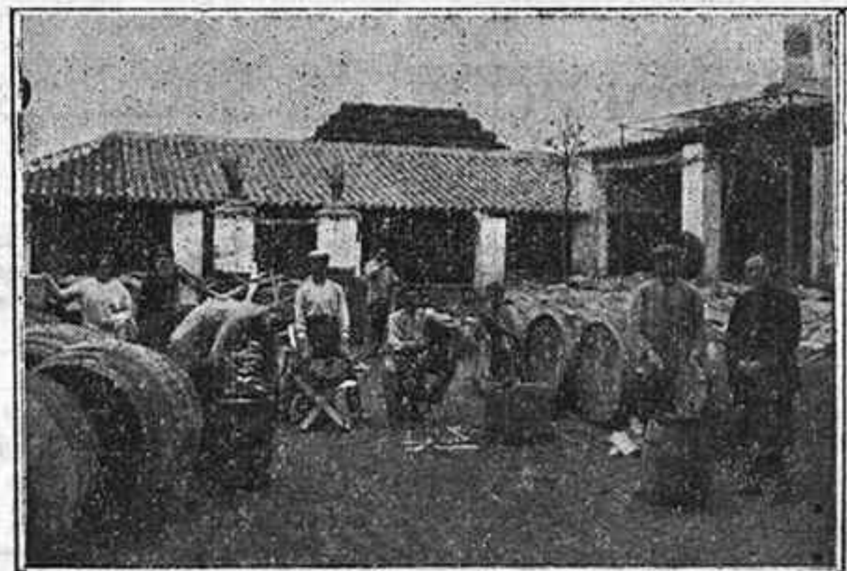
CONSTRUCCIÓN Y REPARACIÓN DE TONELES
