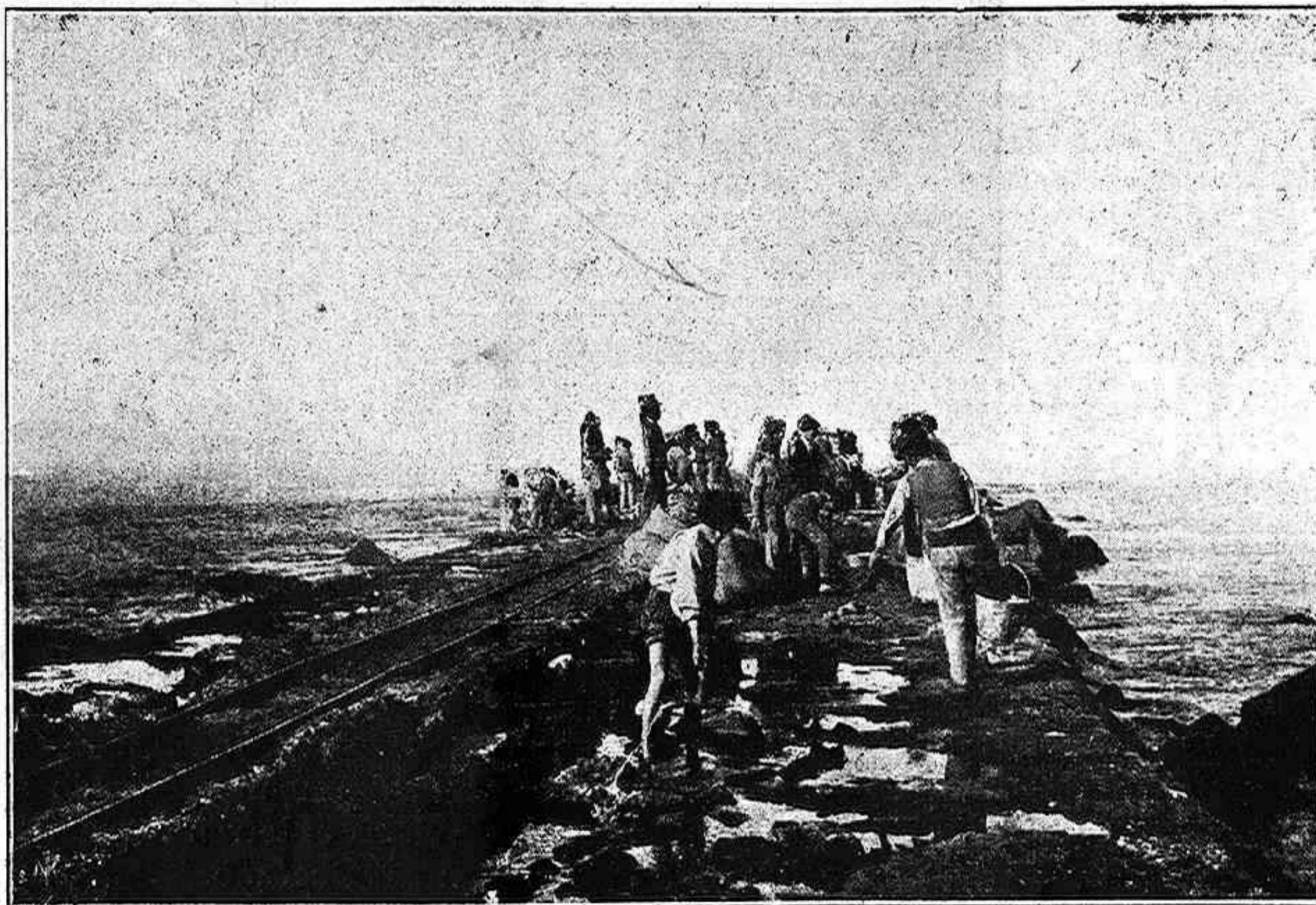
Obreros trabajando en las obras del puerto de San Esteban.
