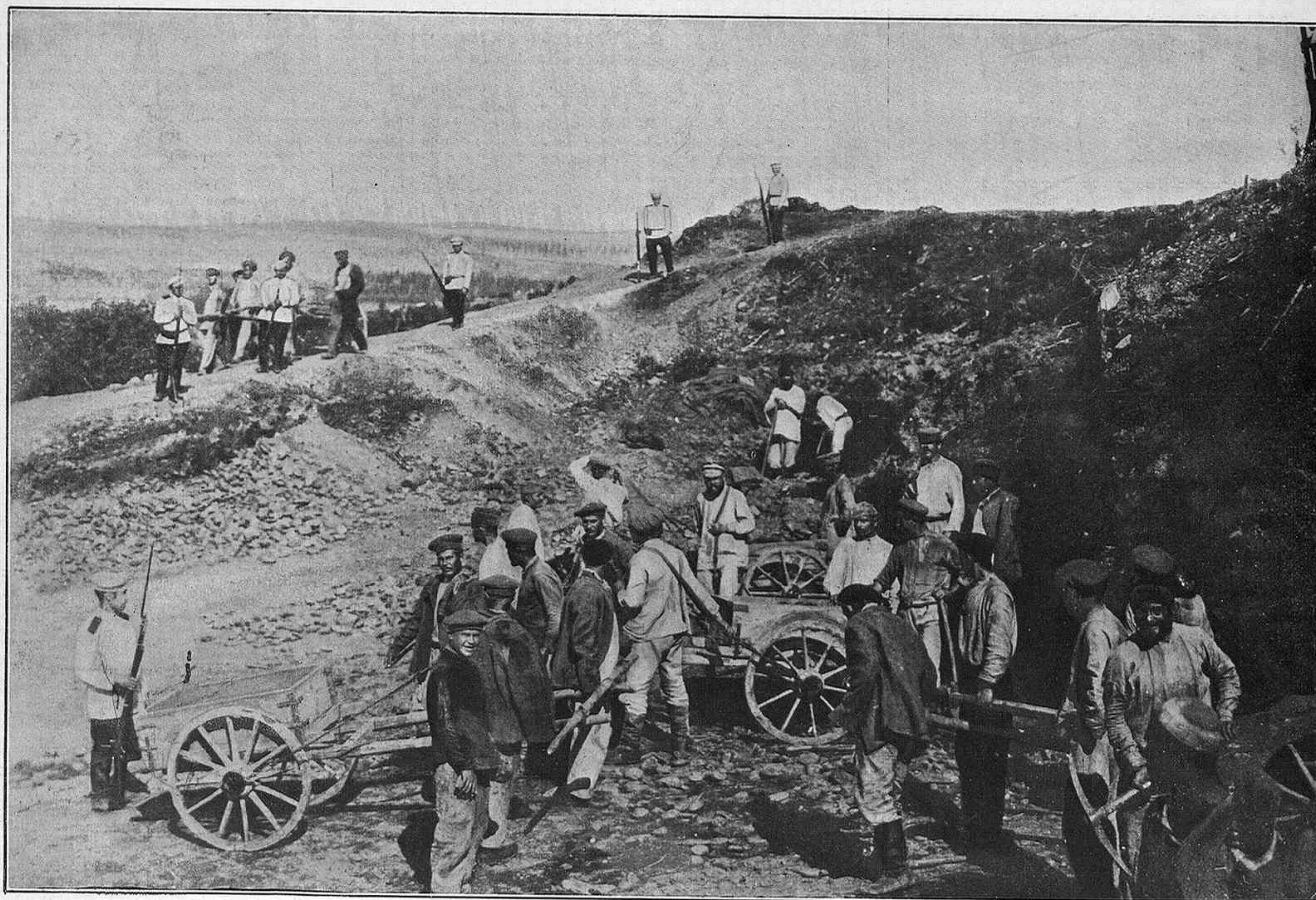
GUERRA RUSO-JAPONESA.— Presidiarios rusos construyendo terraplenes bajo la vigilancia de centinelas rusos. (De fotografía.)
