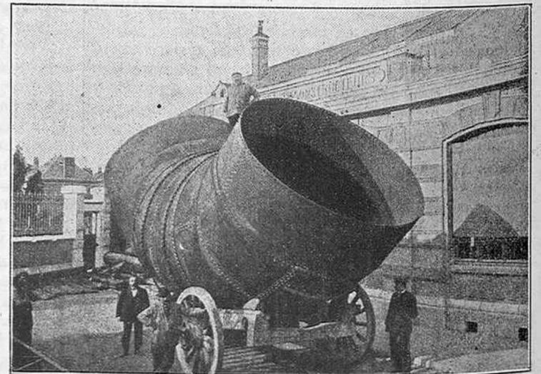
Fig. 3. — Tubo de 3'30 metros de diámetro para la conducción de las aguas del salto de Champs (Grenoble)
