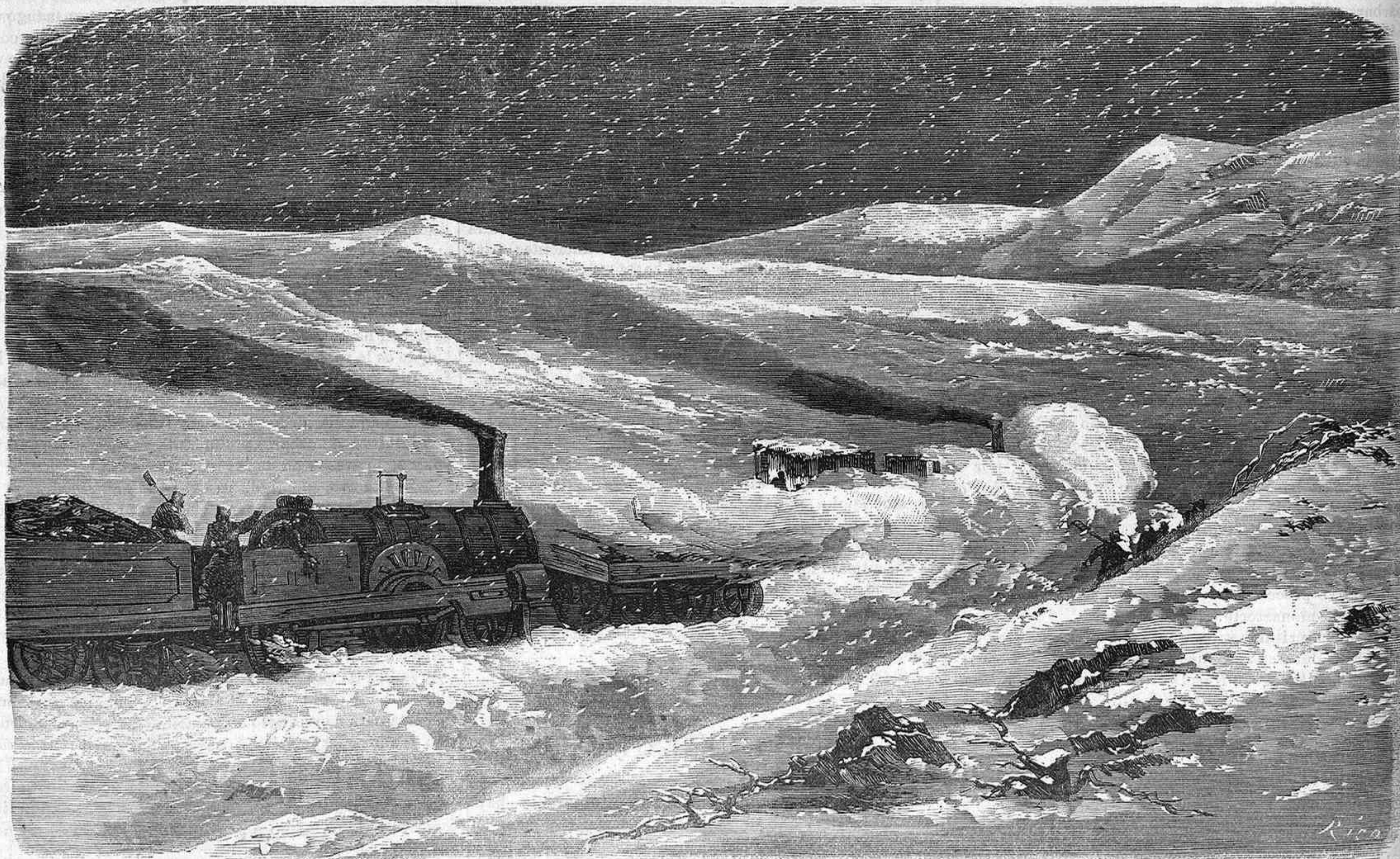
INTERRUPCION DE LA LÍNEA FÉRREA DEL NORTE CAUSADA POR LAS NIEVES ENTRE NAVAL-GRANDE Y ÁVILA.
