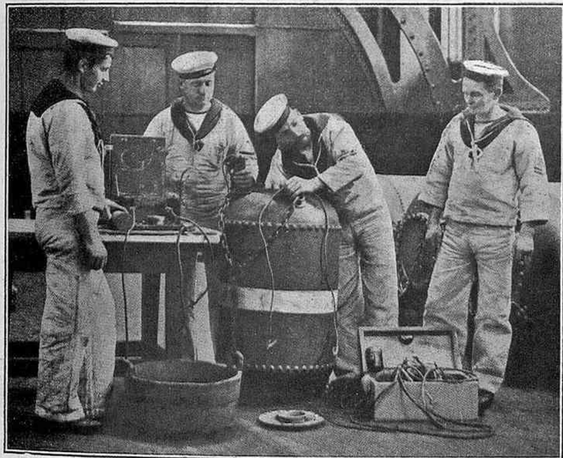
Colocación de los contactos eléctricos en los torpedos fijos
