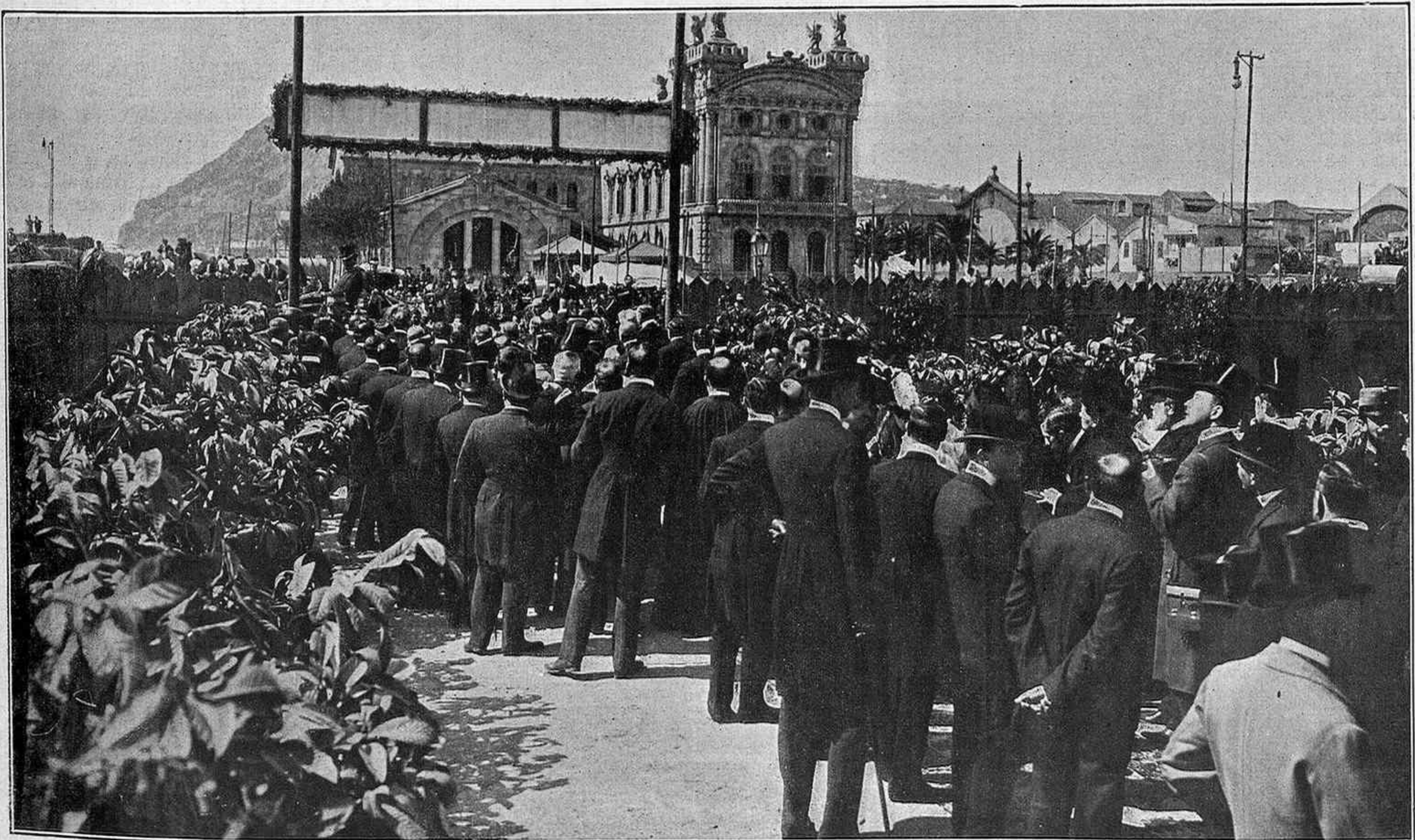
S. M. colocando en el Puerto la primera piedra del edificio para el embarque de viajeros. (De fotografía de A. Merletti.)
