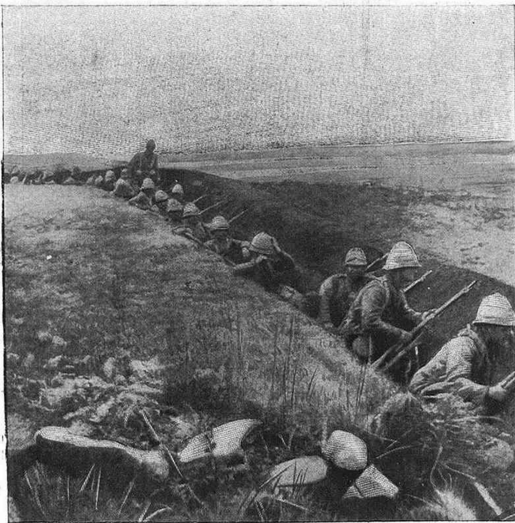
GUERRA ANGLO-BOER. — Trincheras en el campamento de Chieveley (de fotografía)
