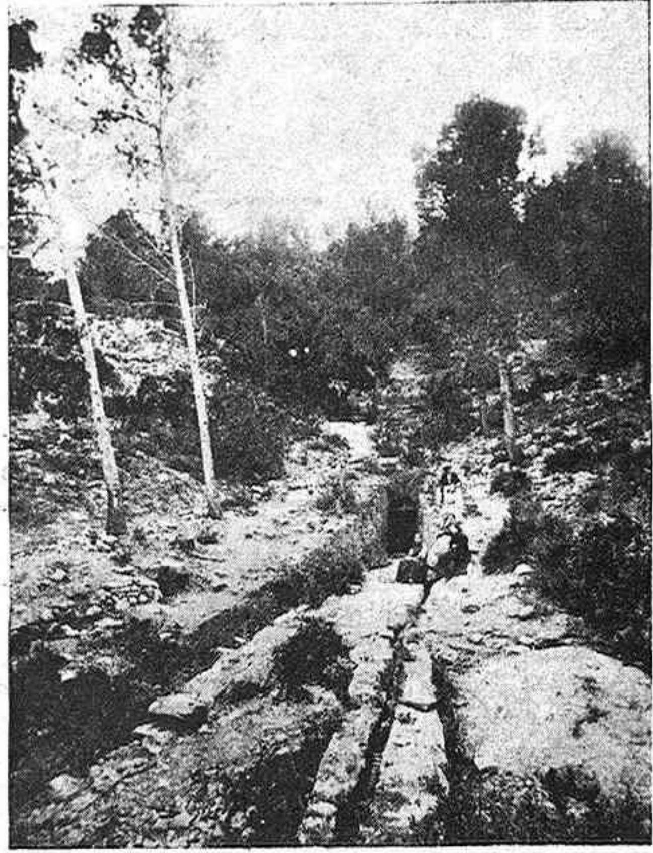
FUENTE DE LA HOYA QUE SURTE DE AGUA AL CONVENTO Y MAYORALÍA POR EL ACUEDUCTO
