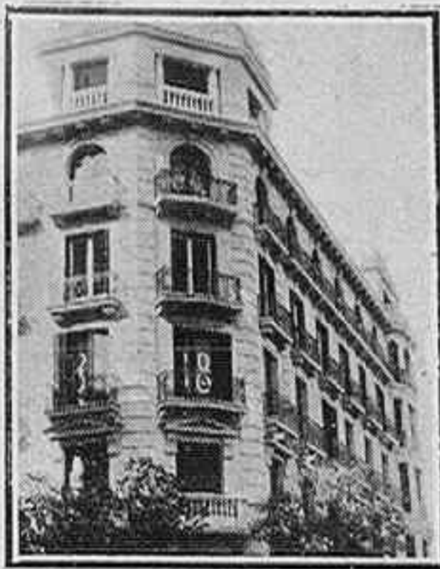
Casa construída en la calle de Zurbarán, esquina á Fortuny, por el arquitecto :: D. Luis de la Peña ::
