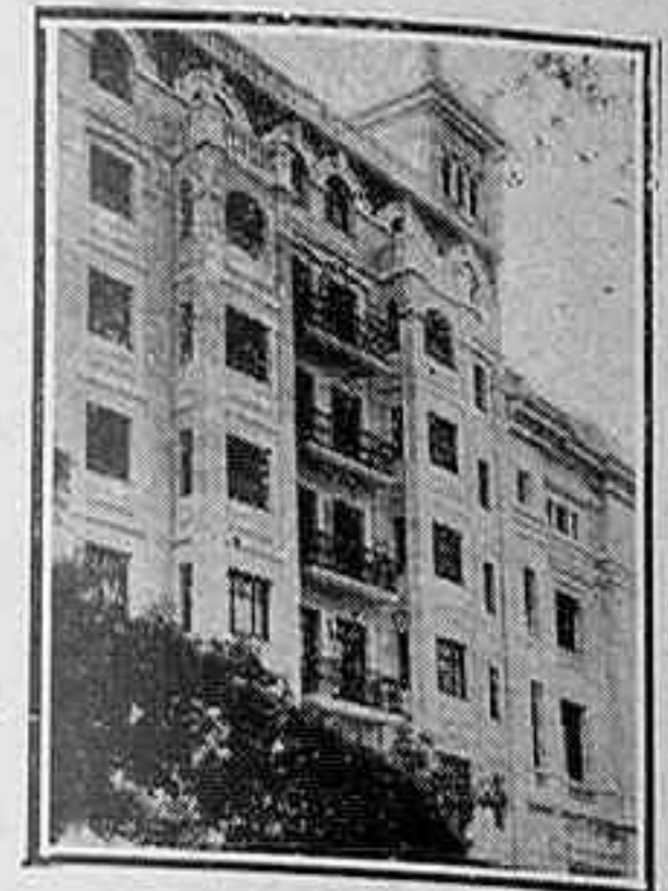
Edificio construído en la calle de Montalbán, número 18, por el arquitecto :: D. Julián Otamendi ::
