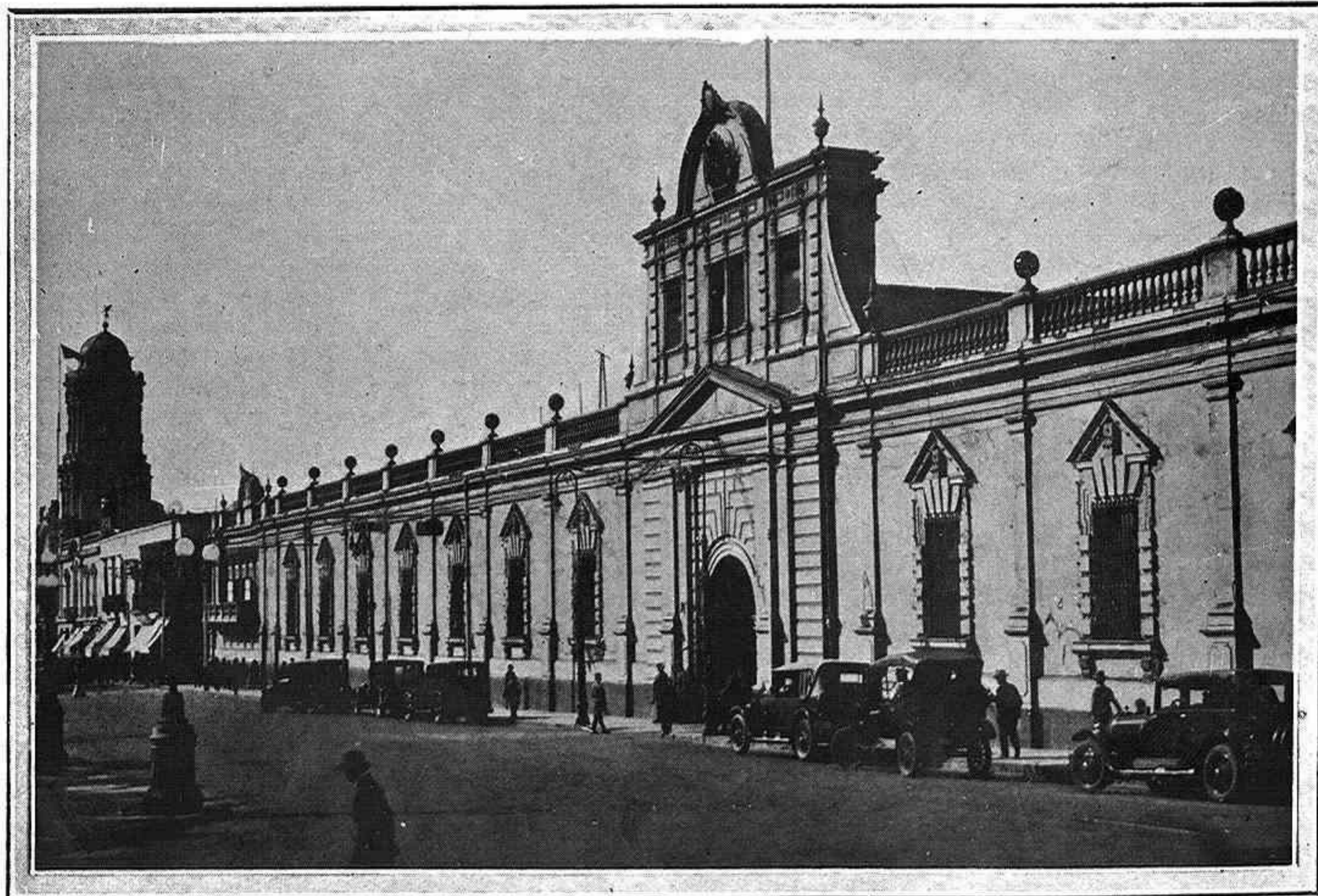
Edificio del Palacio del Gobierno, en Lima
