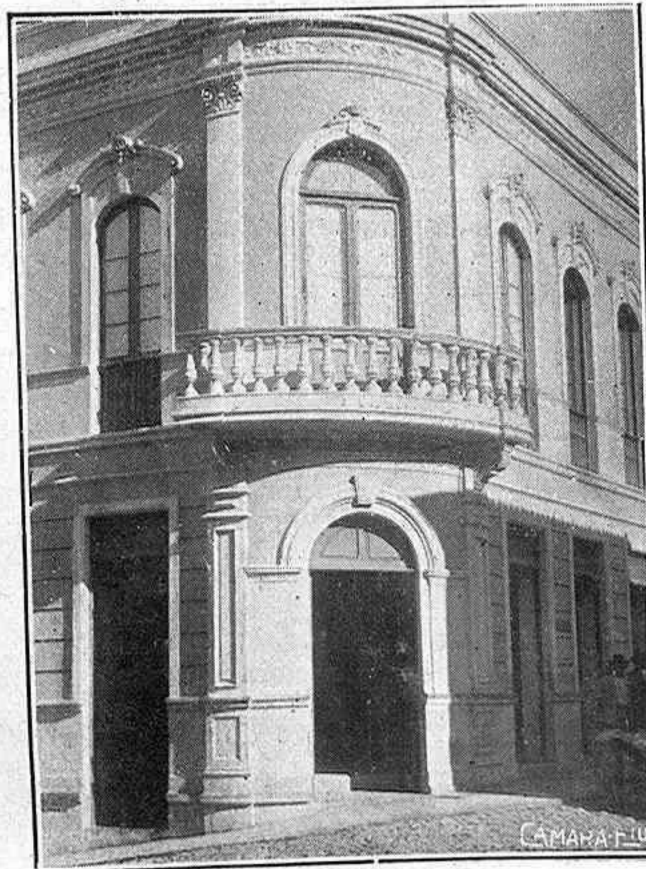
Edificio en el que se halla instalada la Casa de Banca y Cambio de D. Abraham Morales en la calle de la Carrera de la villa de Orotava
