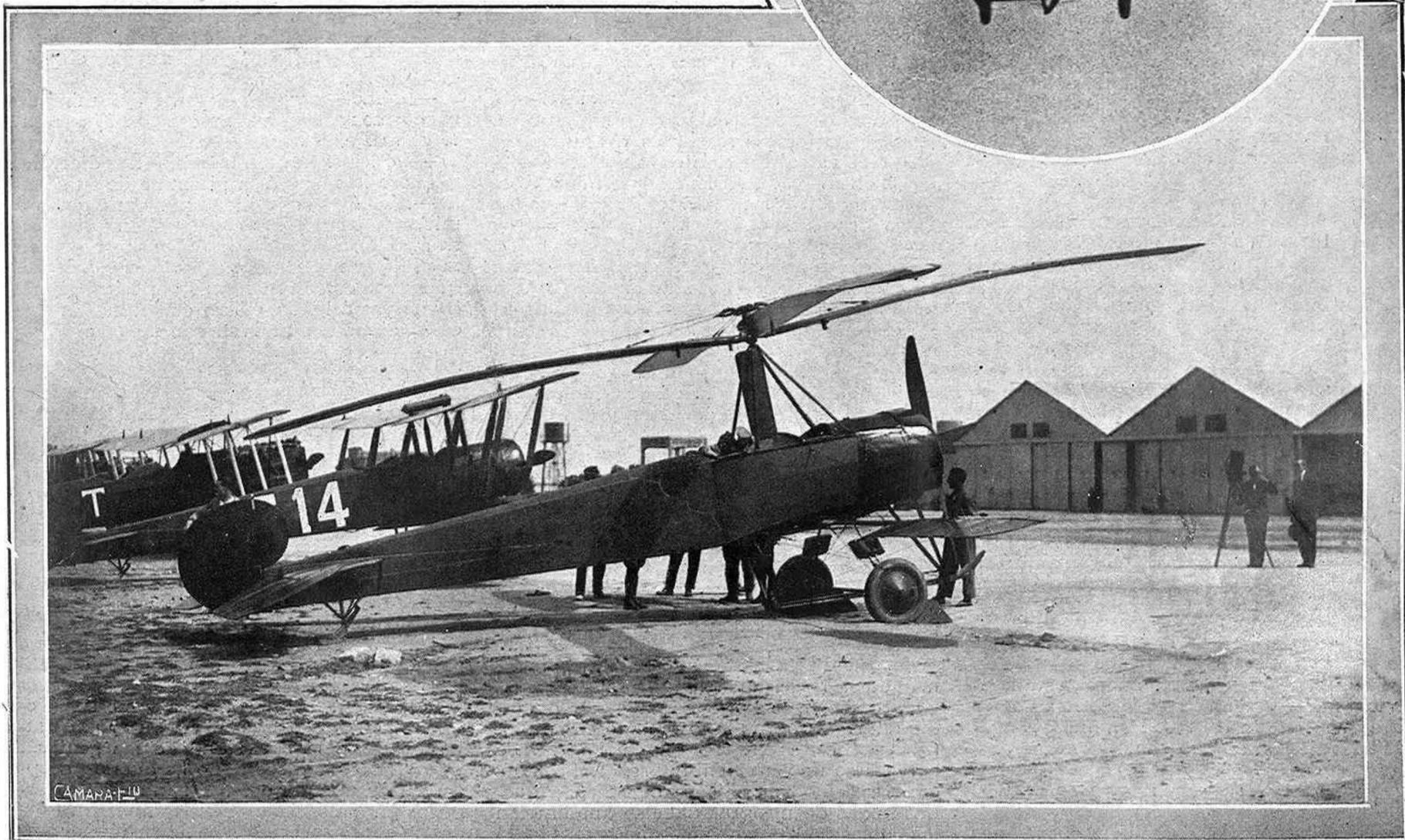
El autogiro visto de cerca. El aparato se diferencia esencialmente de los aeroplanos corrientes en la hélice de cuatro palas montada sobre un fuerte árbol que preside los movimientos de sustentación y descenso casi verticales
