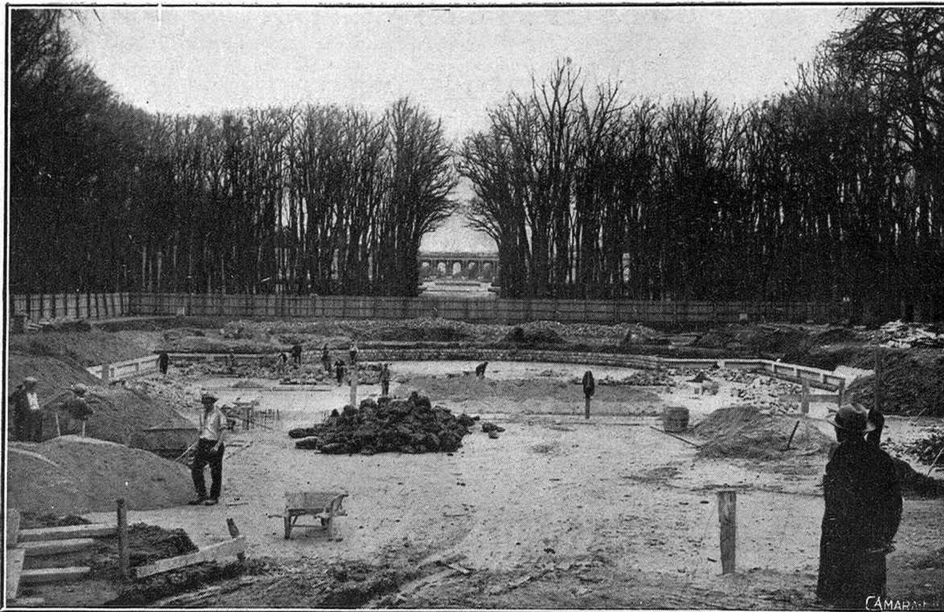
Estado actual de los trabajos de reconstrucción de las fuentes de Versalles que costea Rockefeller
