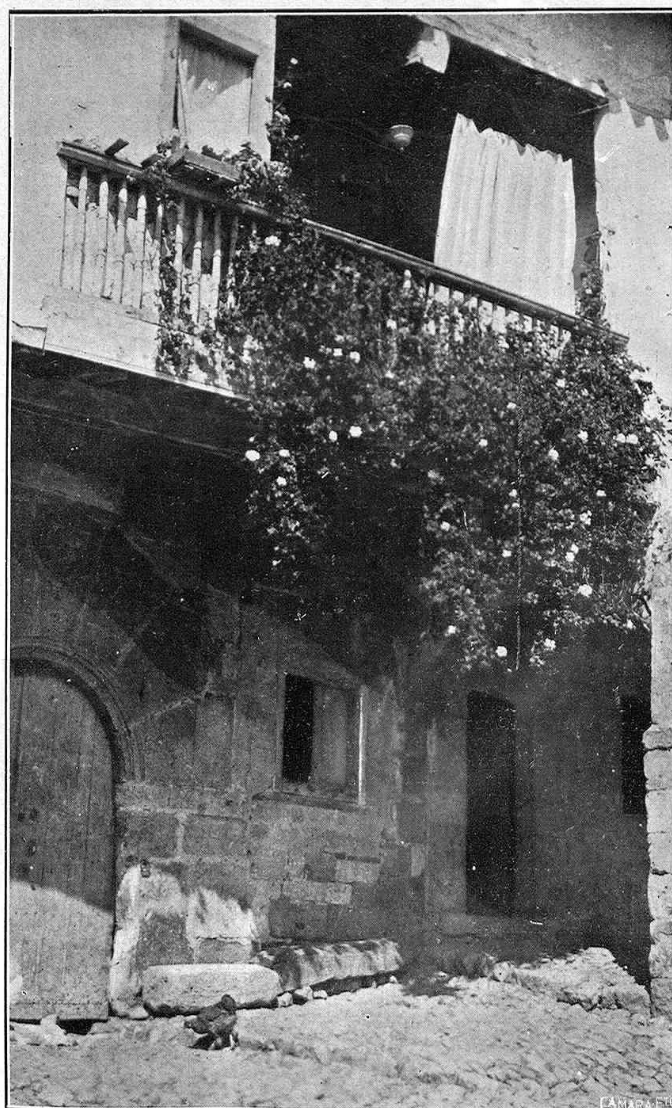
Detalle de una casa
