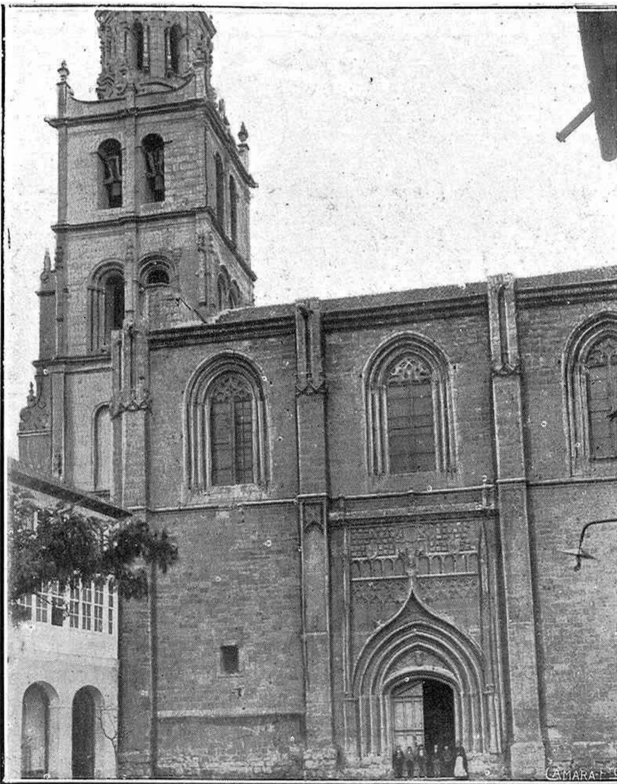
Vista exterior de la iglesia
