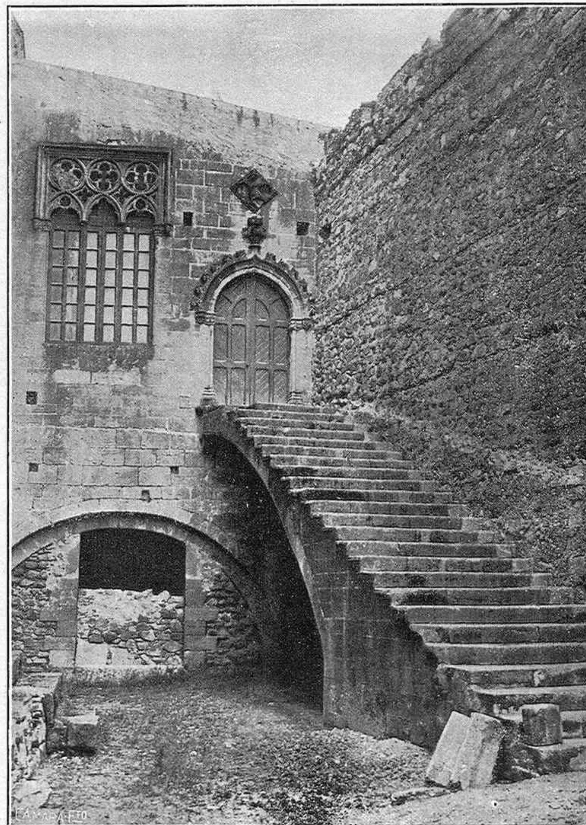
Escalera del palacio del rey D. Martín, contiguo al Monasterio
