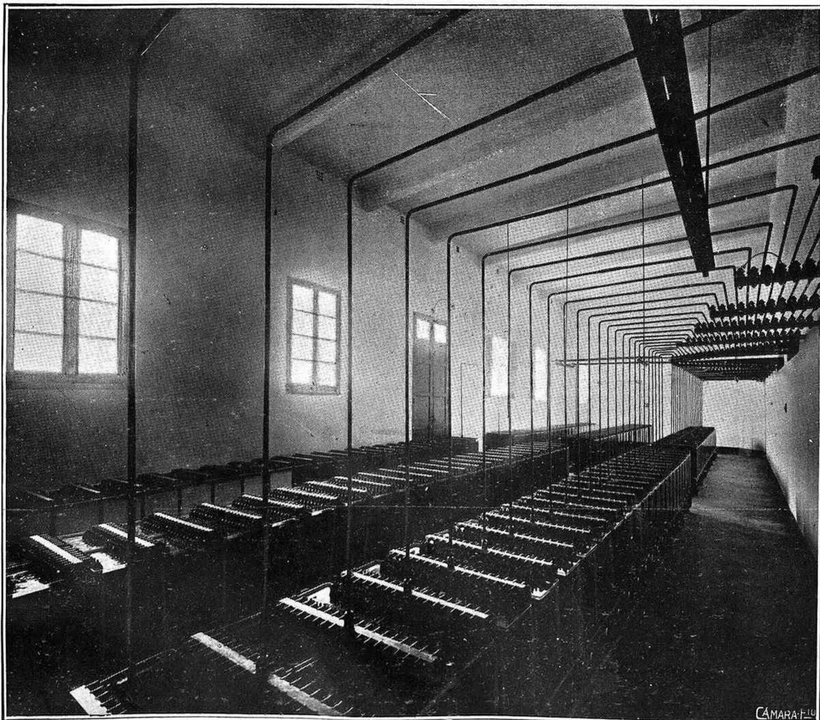
Sala de baterías de la Subcentral
