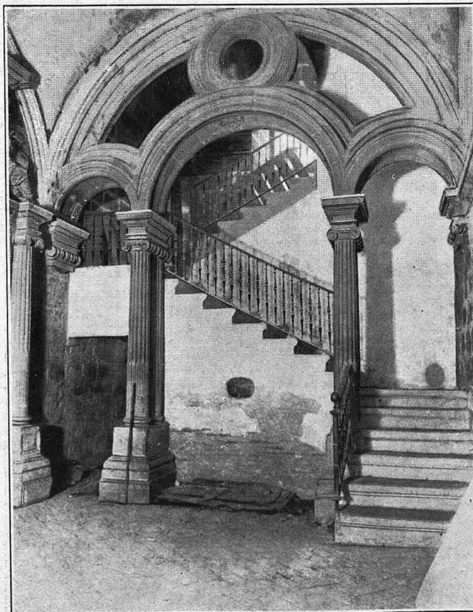
Arco que da entrada a los sotanos
