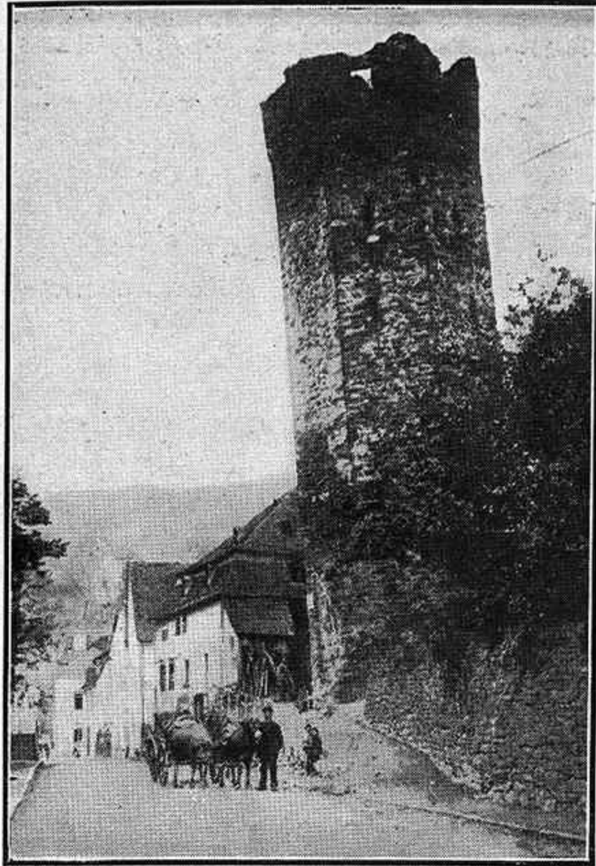
La torre inclinada de St. Maurice
