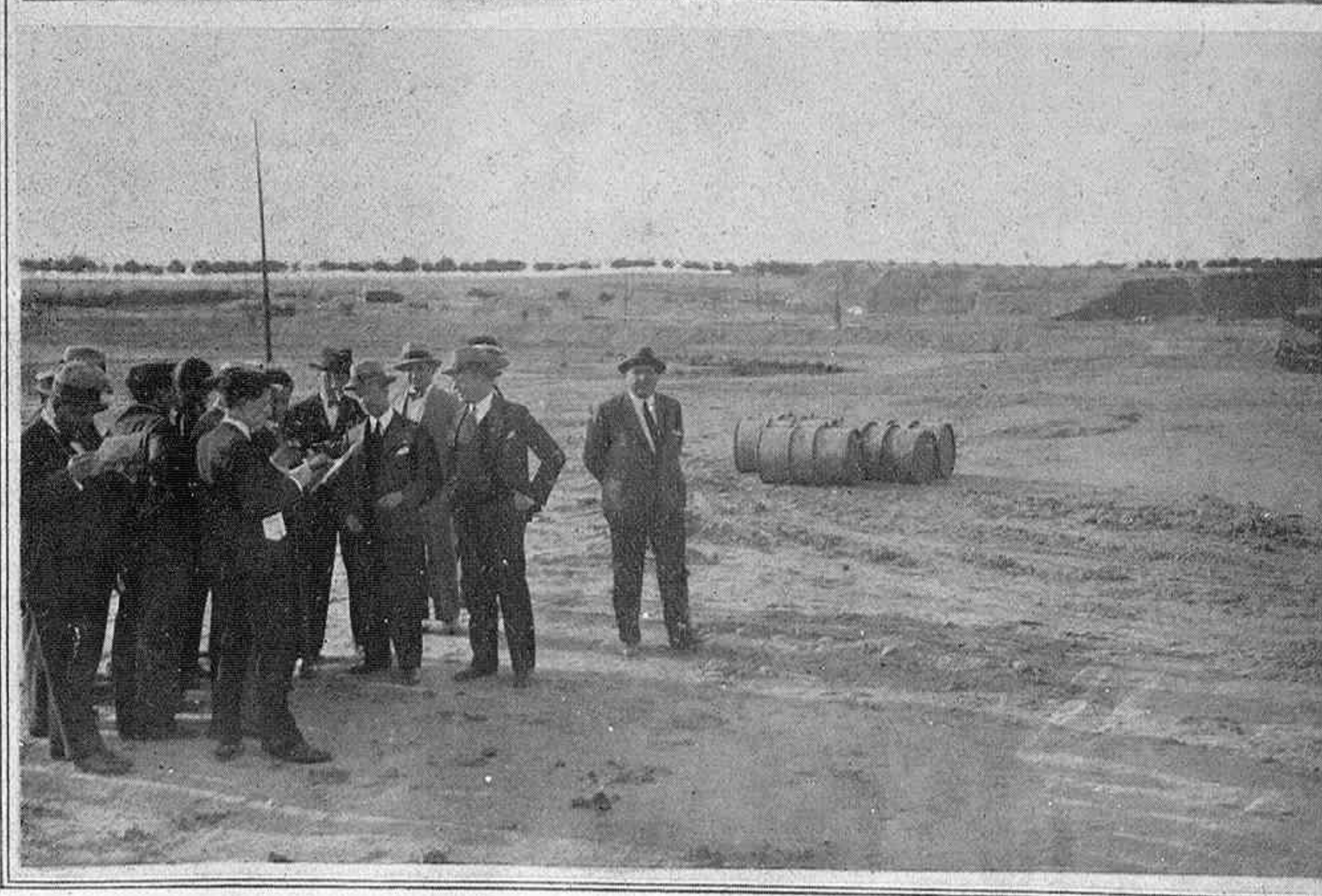
1. Estado en que se hallan, muy adelantadas ya, las obras de la Residencia Fundación Del Amo.—2. Una de las modernas máquinas excavadoras que se emplean en los trabajos de nivelación del terreno.—3. El ministro de Instrucción Pública mostrando á varios periodistas los planos de la Ciudad Univeersitaria, durante la visita á las obras (Fots. Cortés)
