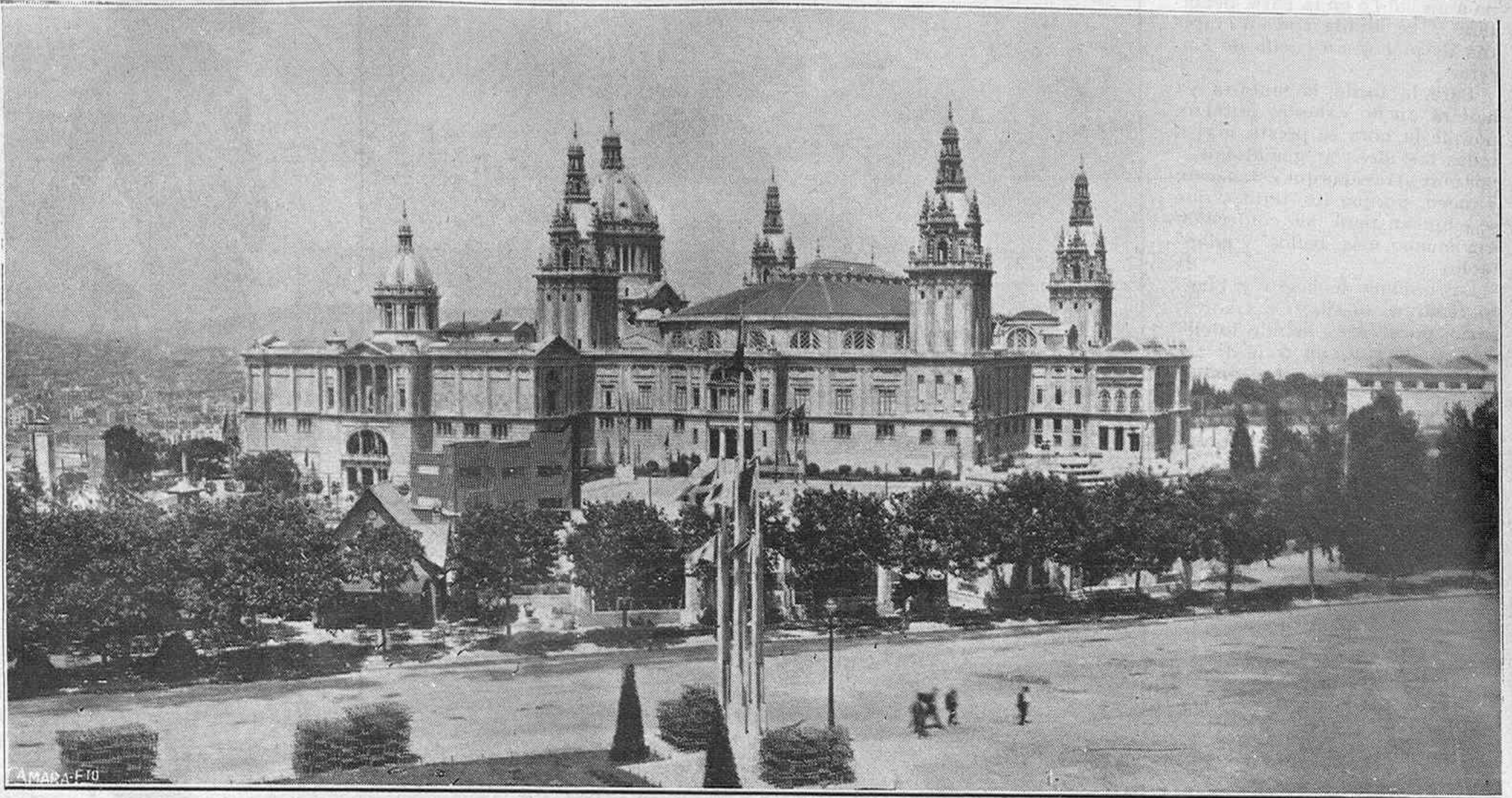
Vista general del Palacio Nacional, construido, gran parte de él, con materiales hidráulicos «Griffi»
