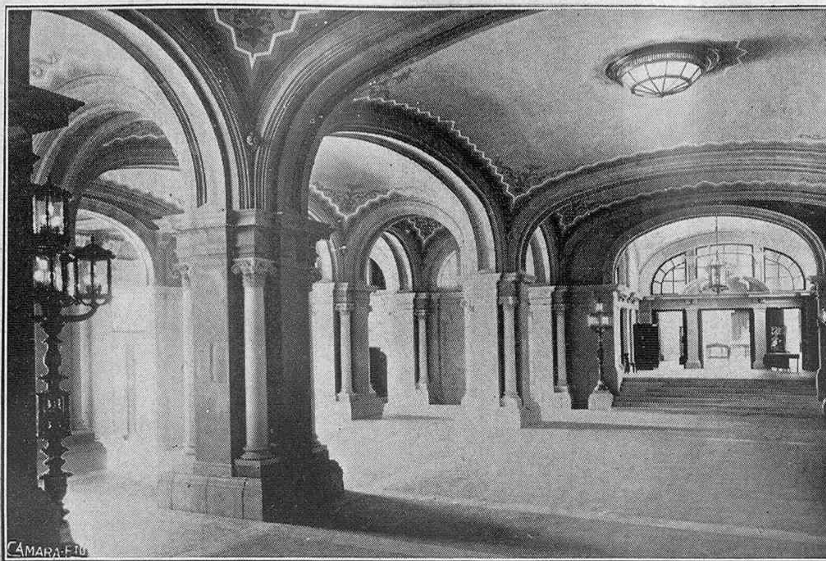
Vestíbulo de entrada al Palacio Nacional, cuya decoración ha sido ejecutada por el pintor D. Aurelio Tolosa y construido con materiales hidráulicos «Griffi»
