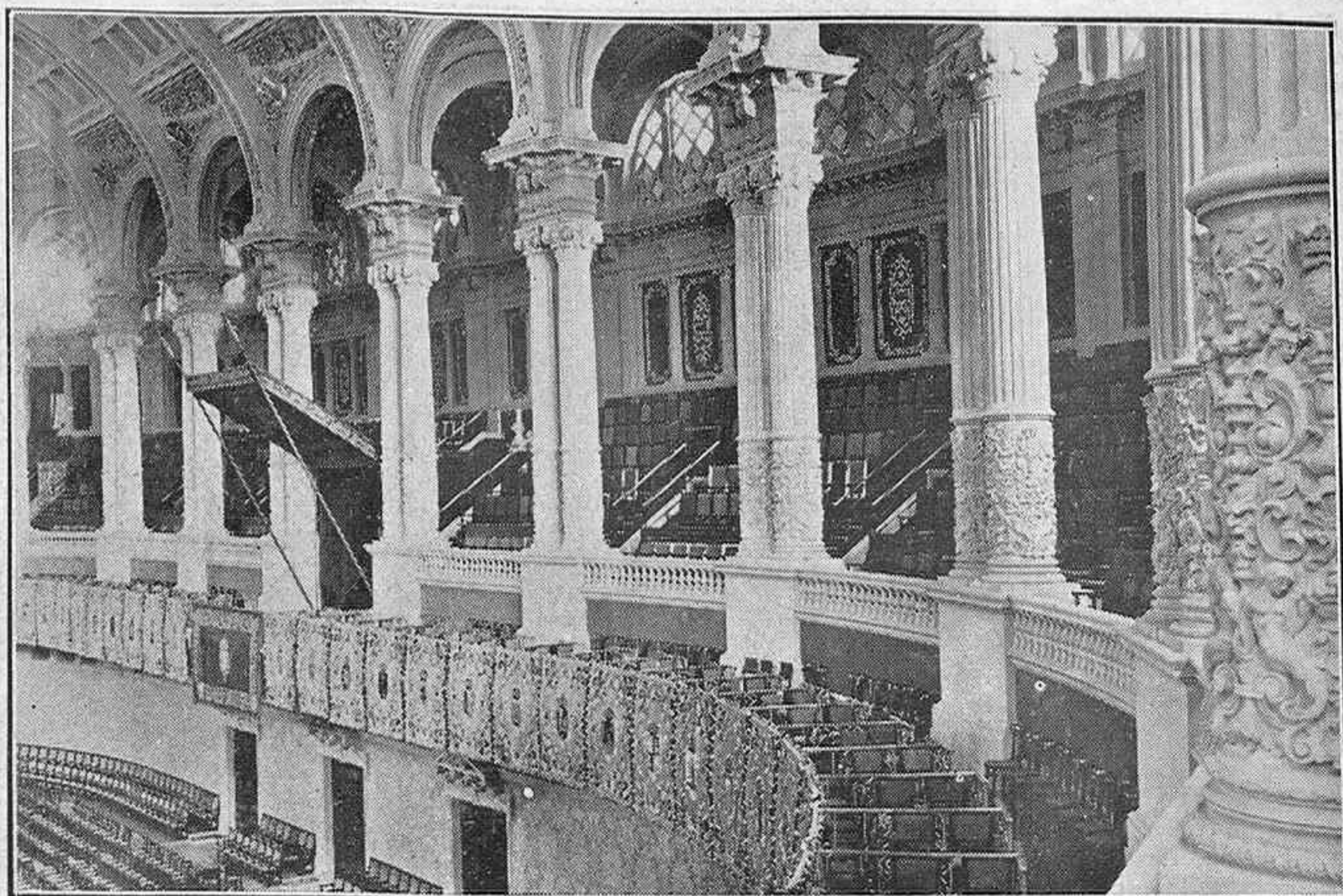
Salón de fiestas. Palco presidencial. Balastradas y columnas construidas con cemento «Griffio»
