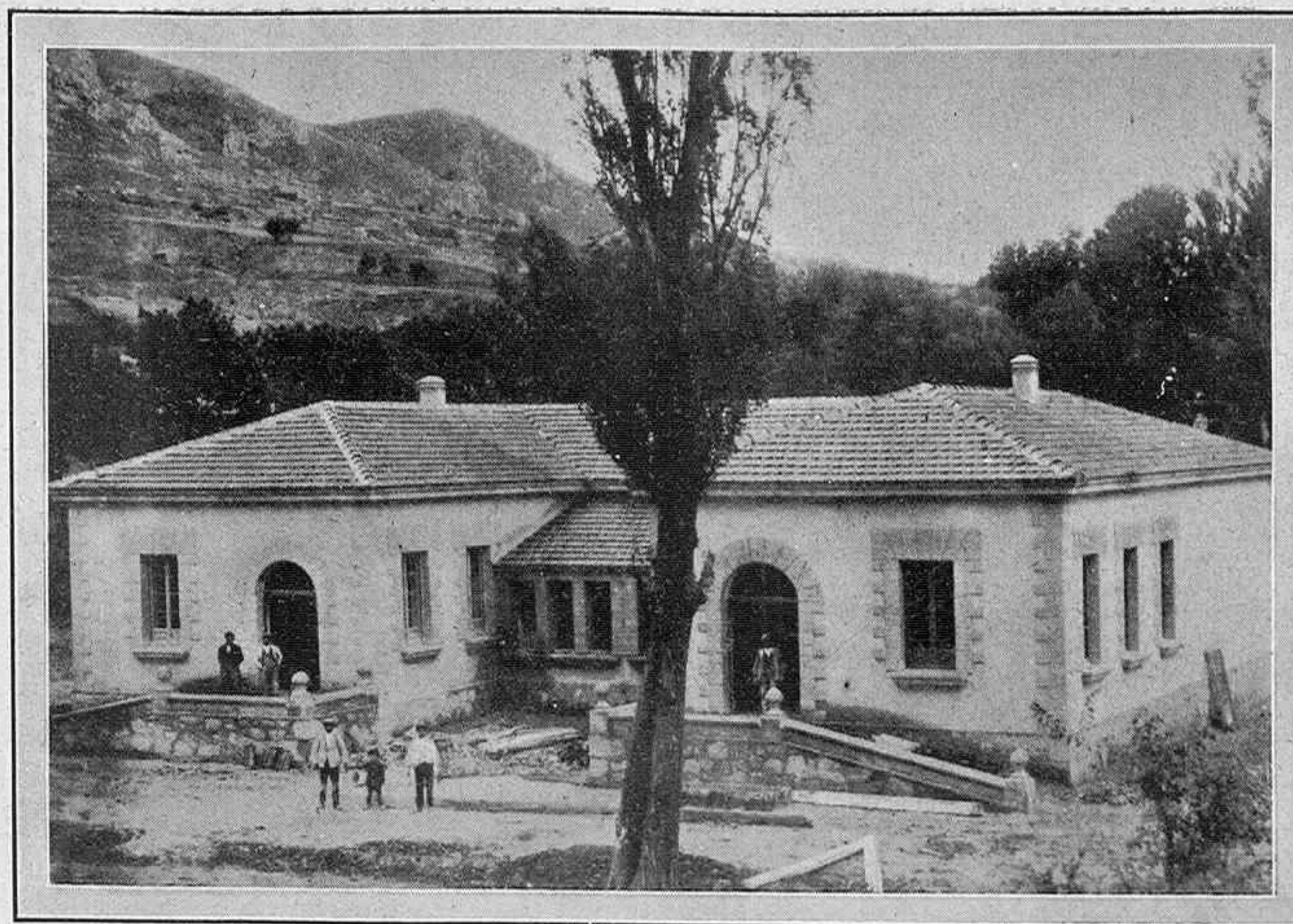
Las nuevas Escuelas de Pancorbo, recientemente inauguradas
