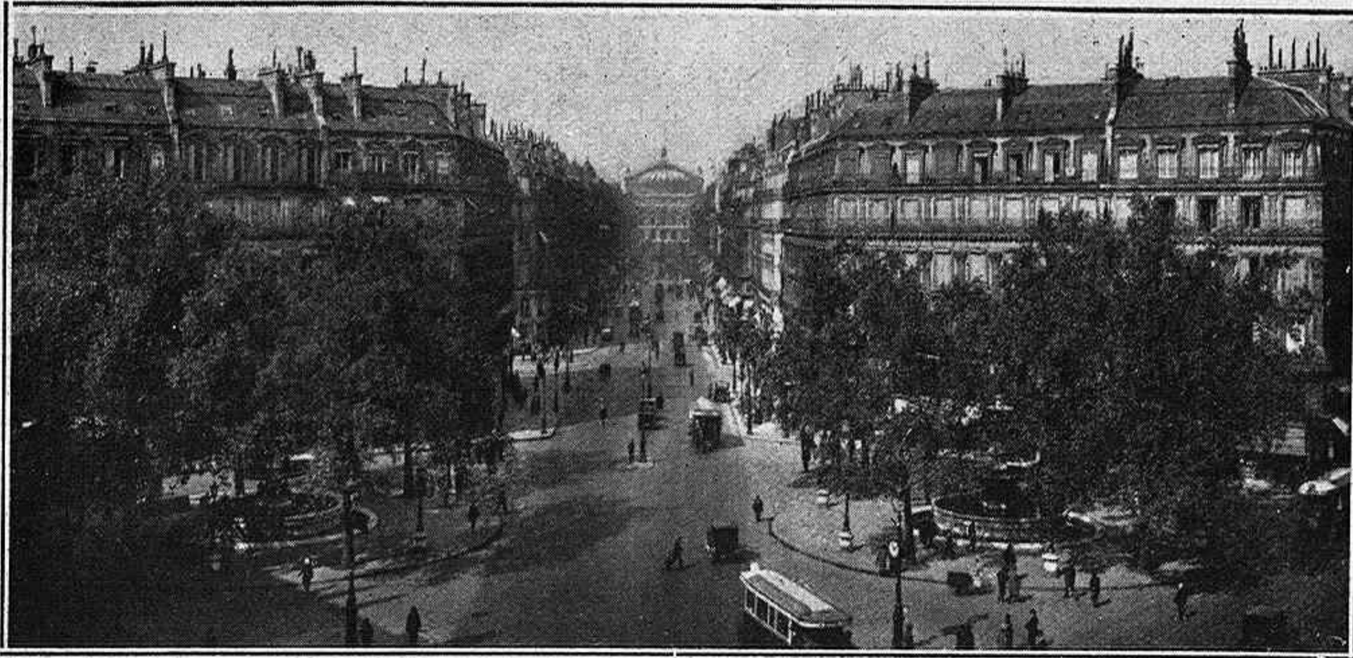
La Avenida de la Opera, vista desde la plaza del Teatro Francés
