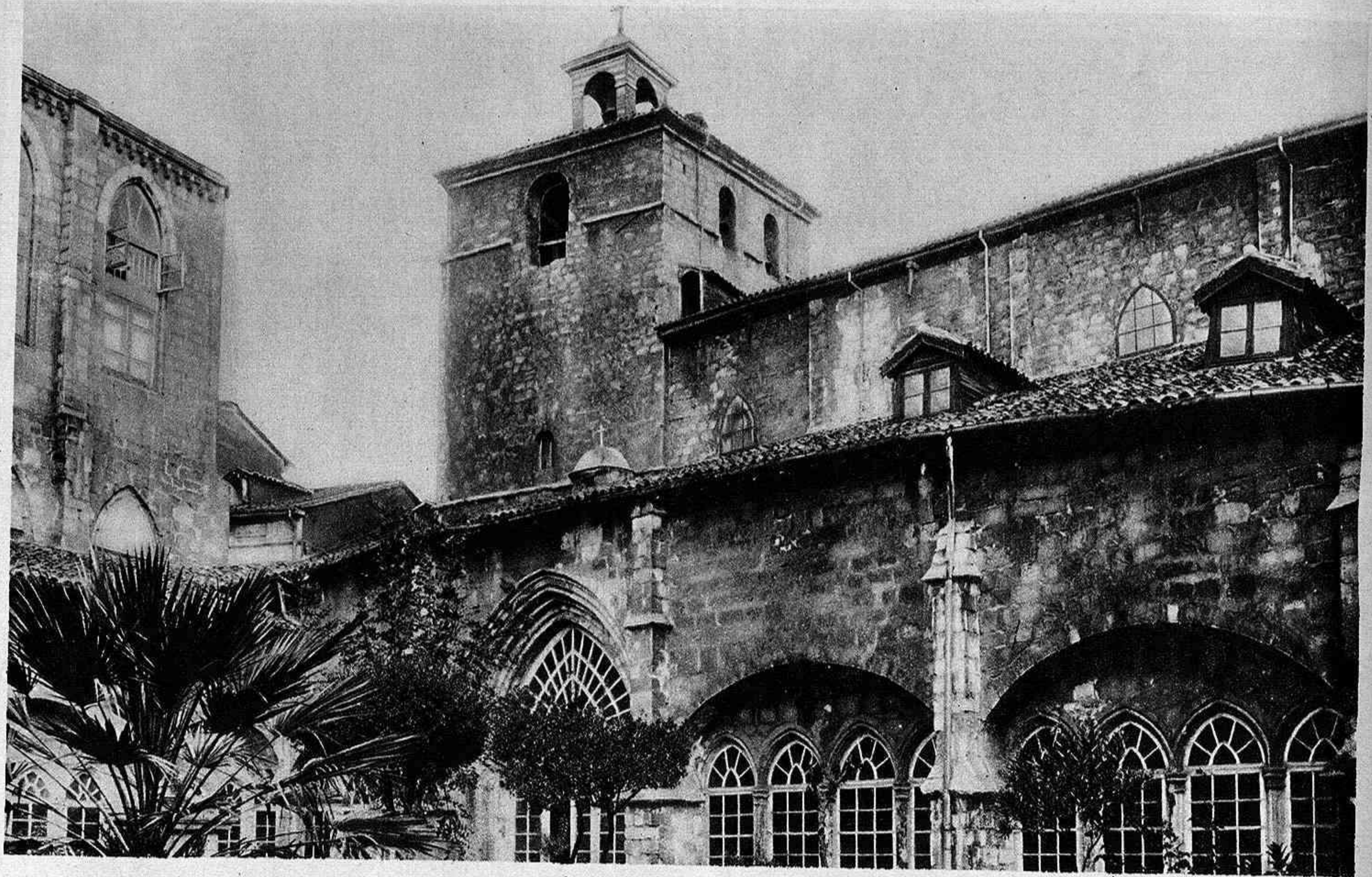
Vista parcial del patio
