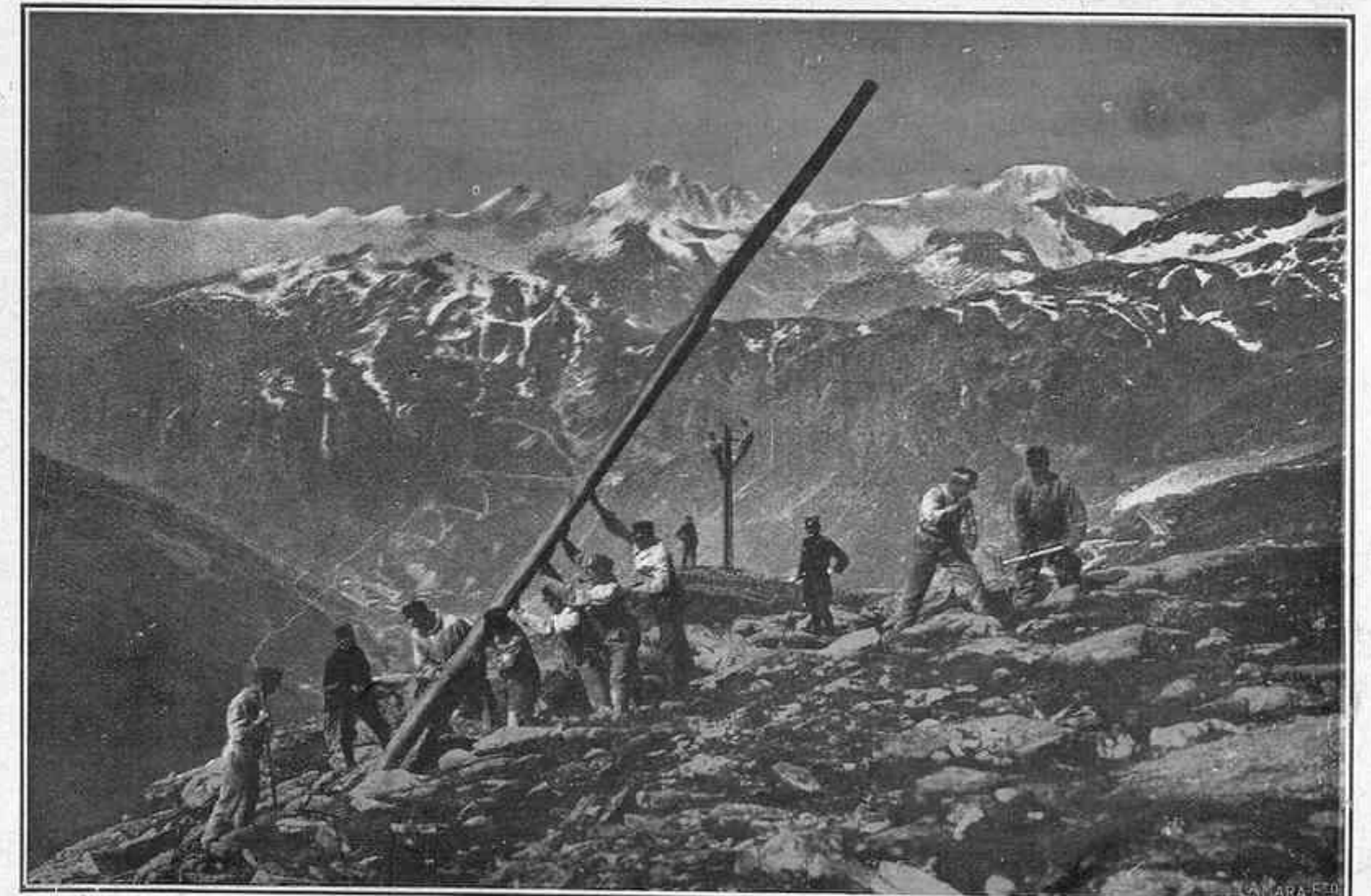
Soldados colocando un poste para la instalación de una línea telefónica
