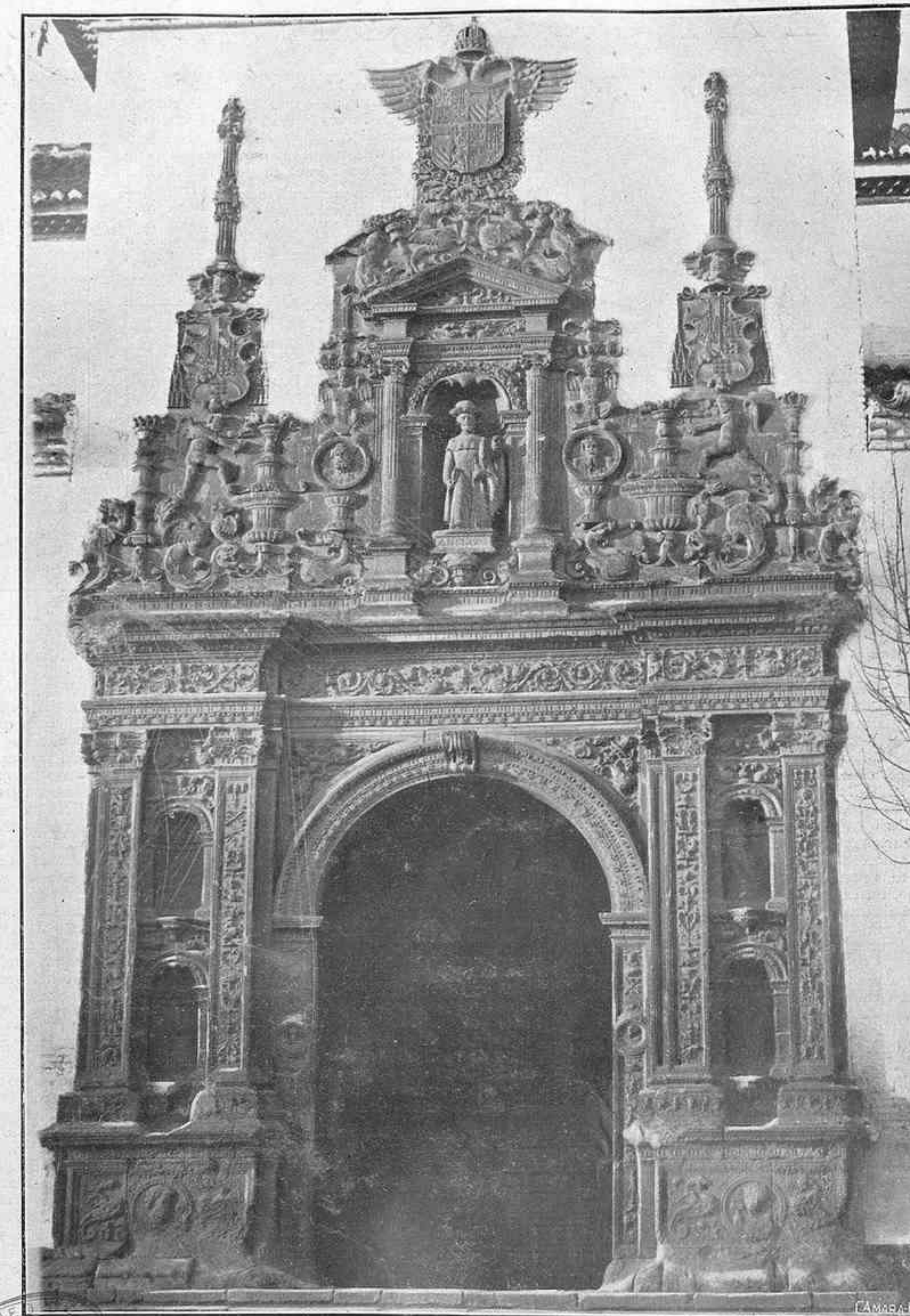
Fachada de la iglesia de Santiago, en Guadix (Granada)
