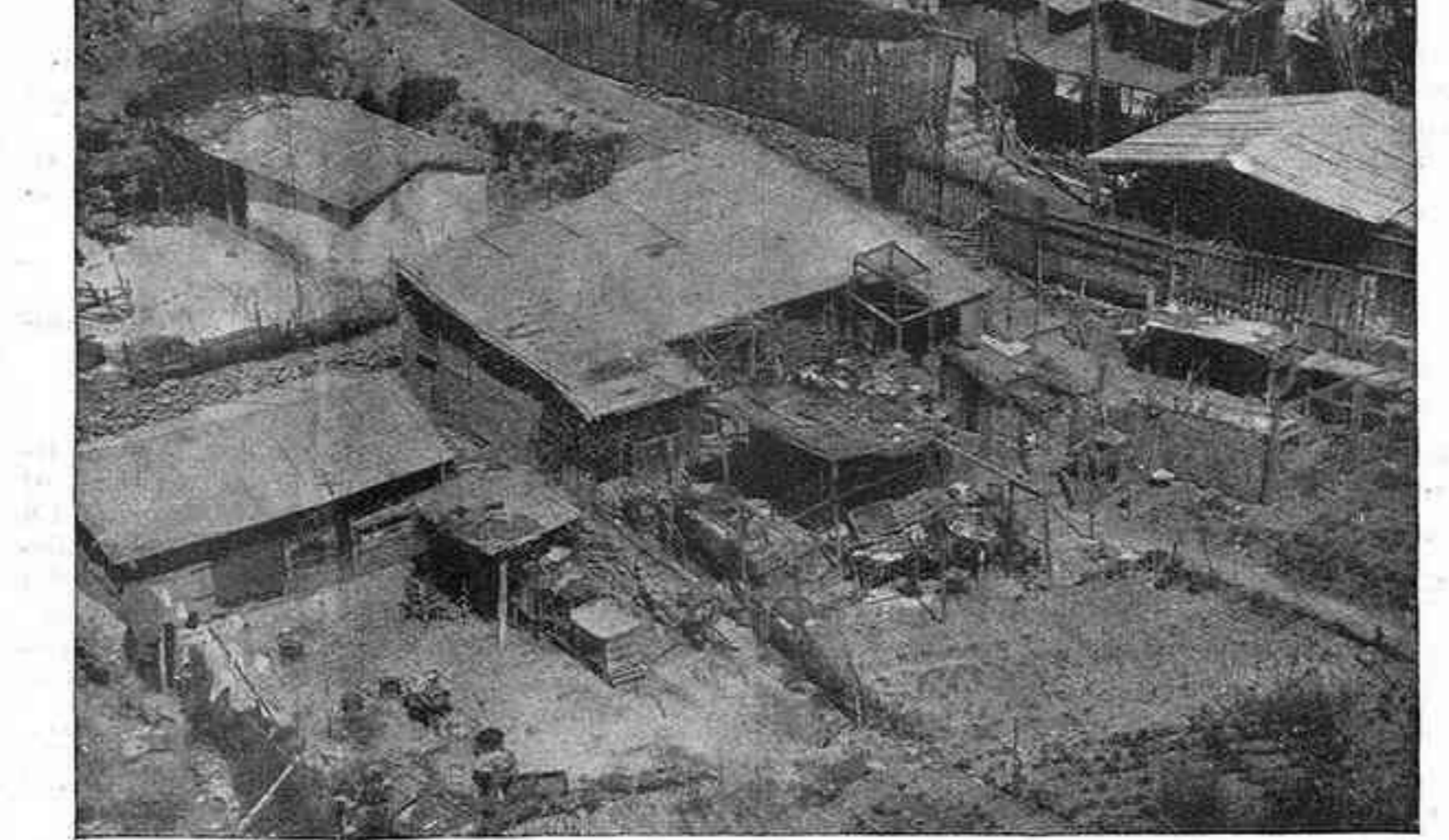
Sort que el sol ho purifica tot...
