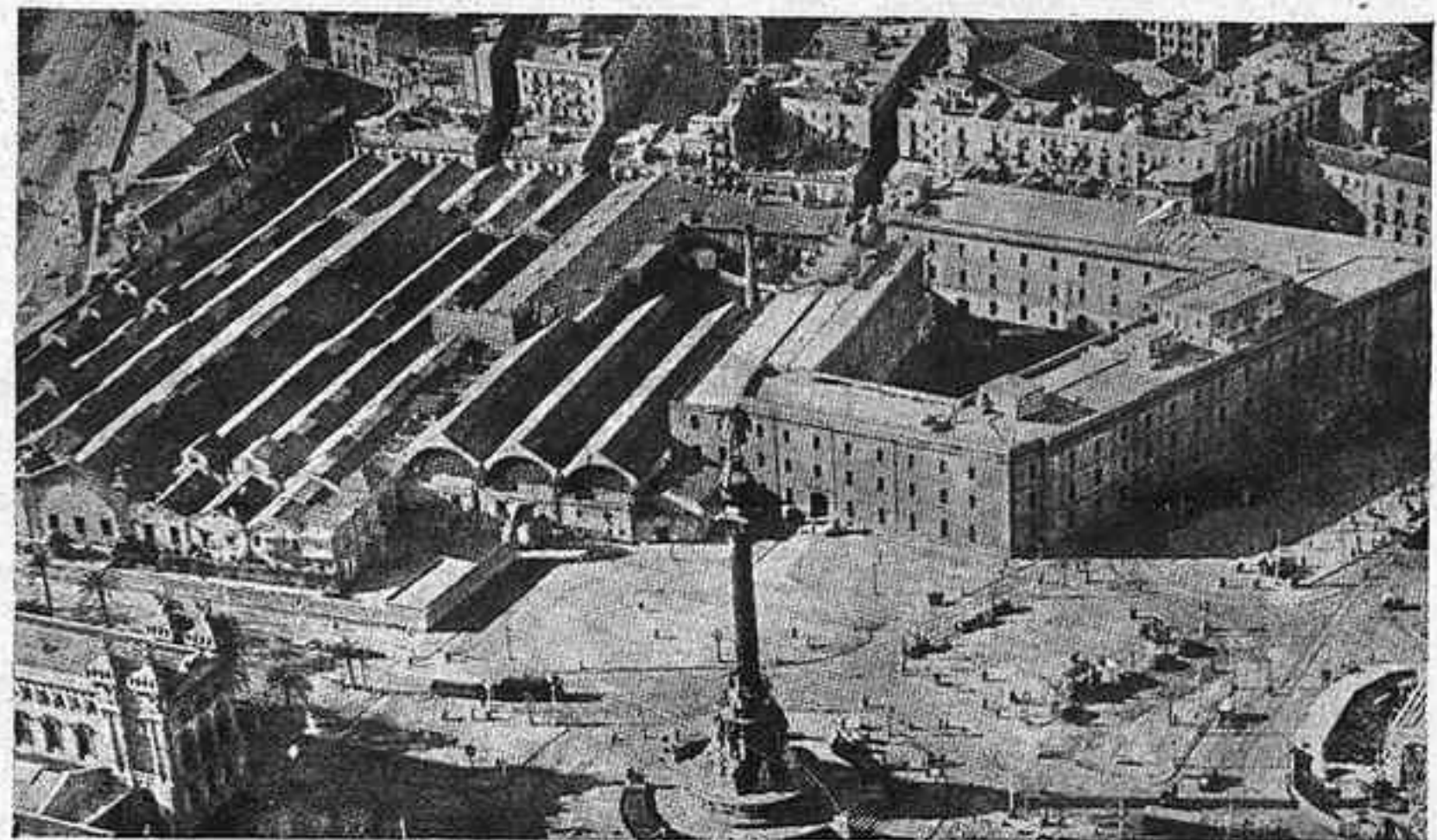
Vista obria de les Drassanes
