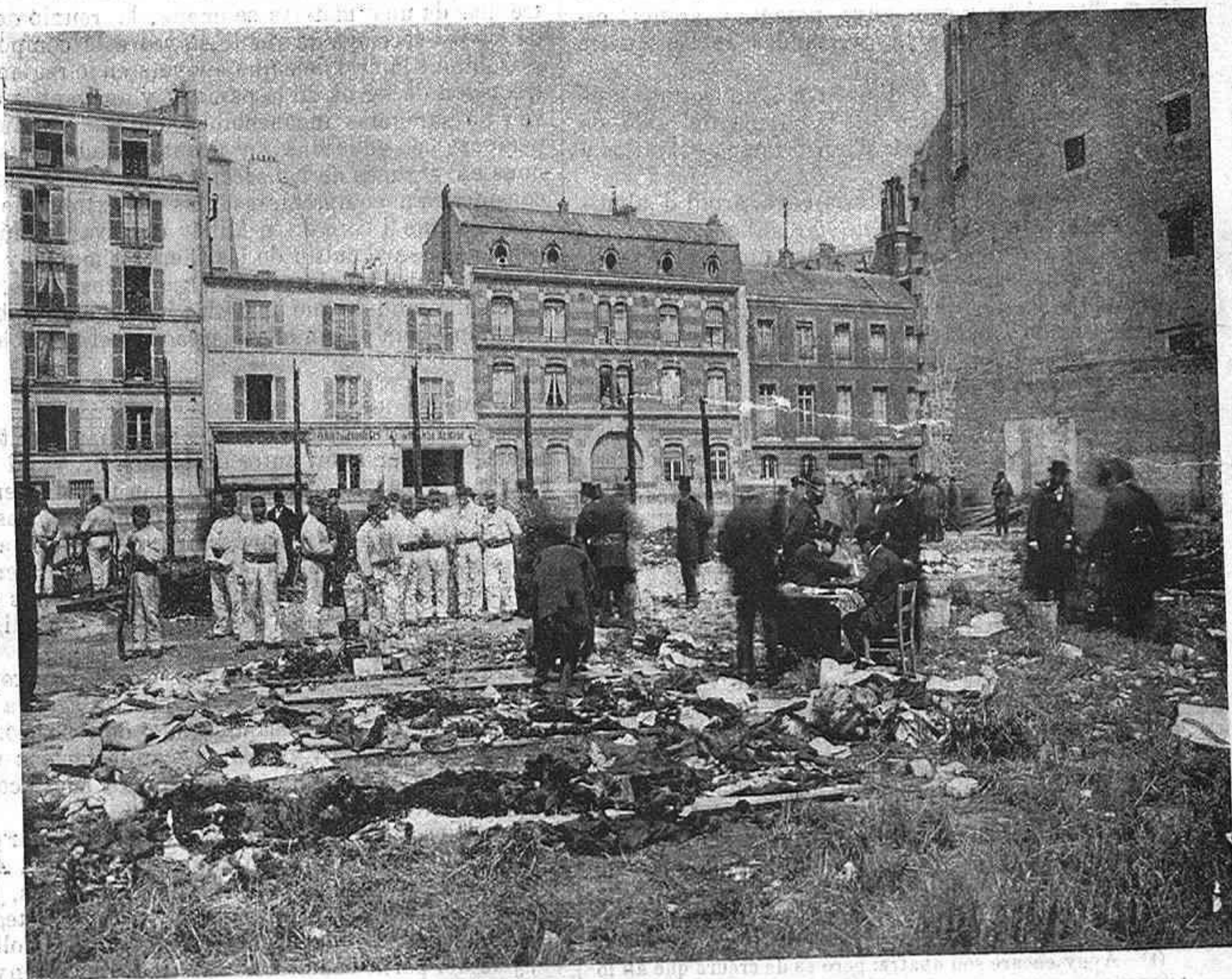
Lo solar del Bassar després del incendi.—Reconeixement dels objectes trobats.
