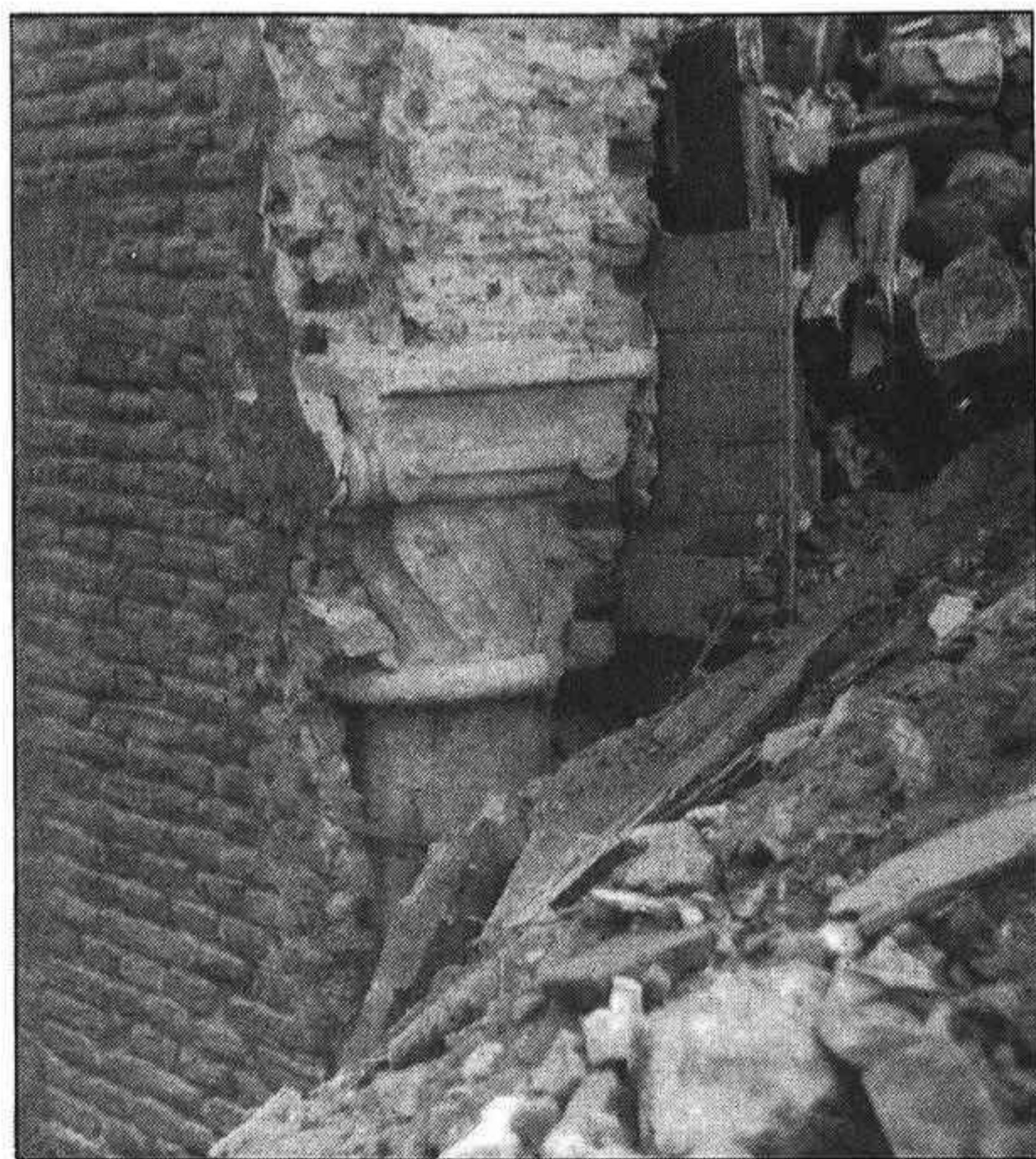
Este capitel y columna fue derrumbado por la pala excavadora. Ahora se encuentra en el Ayuntamiento a la espera de conocer su destino.
