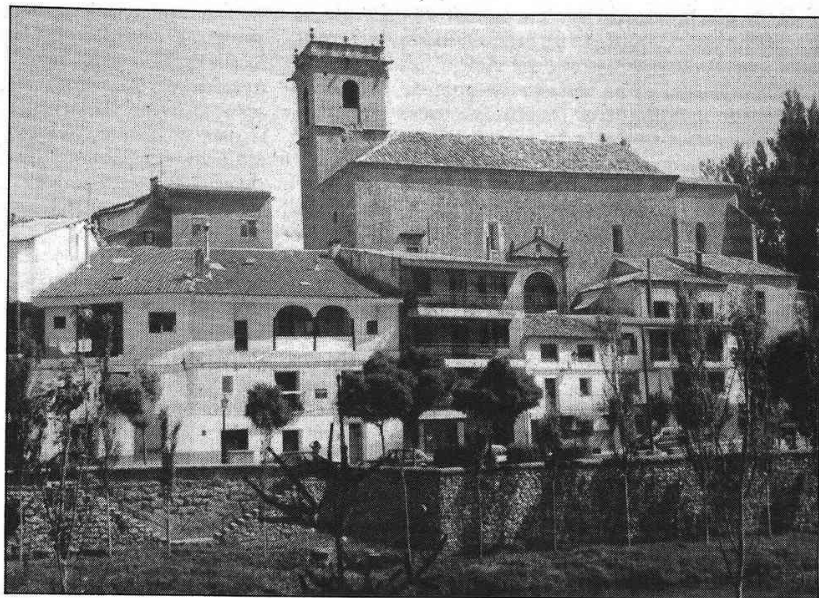
Actualmente se está instalando en la iglesia de Trillo (en la fotografía) el retablo de Santamera. Ya hay 12 pinturas restauradas y faltan 7.
