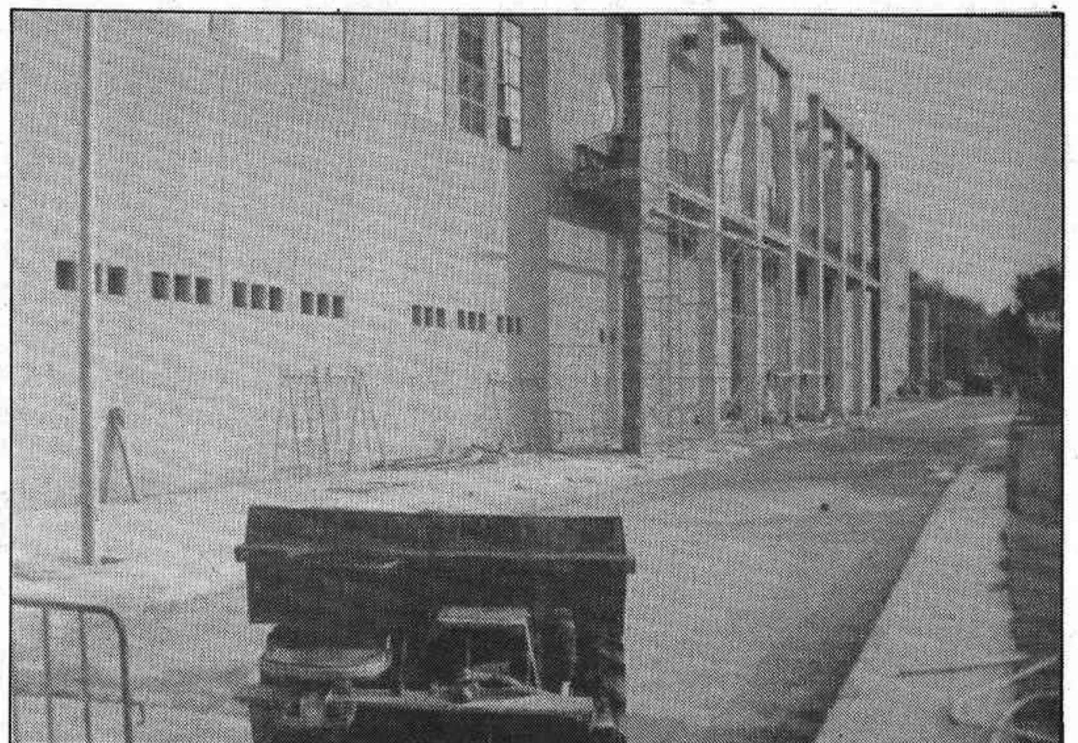
Las obras del Polideportivo están a punto de terminarse y se inaugurarán el día 5
