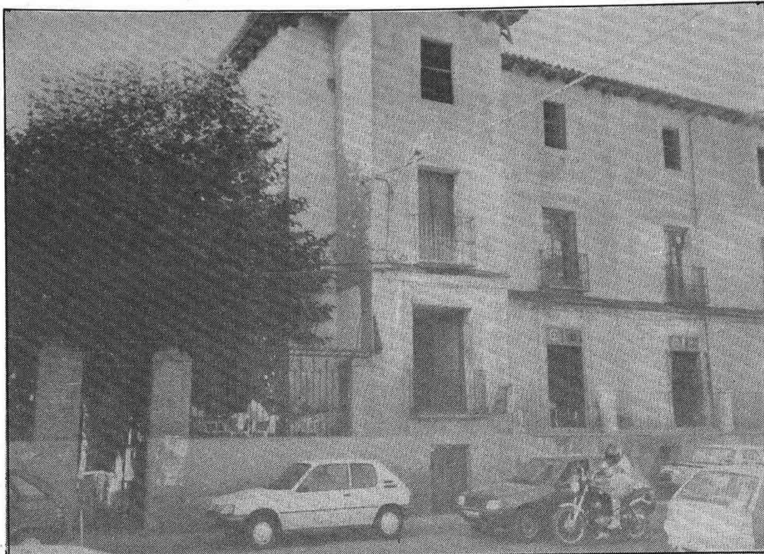
El Casino va necesitando unas obras de reforma
