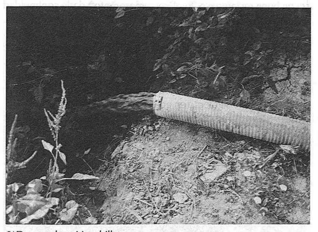
3)Depuradora Hurchillo Se observa cómo la manguera que previamente salía de la depuradora, vierte aguas fecales en el cauce del Reguerón y luego esa agua se utiliza para el riego
