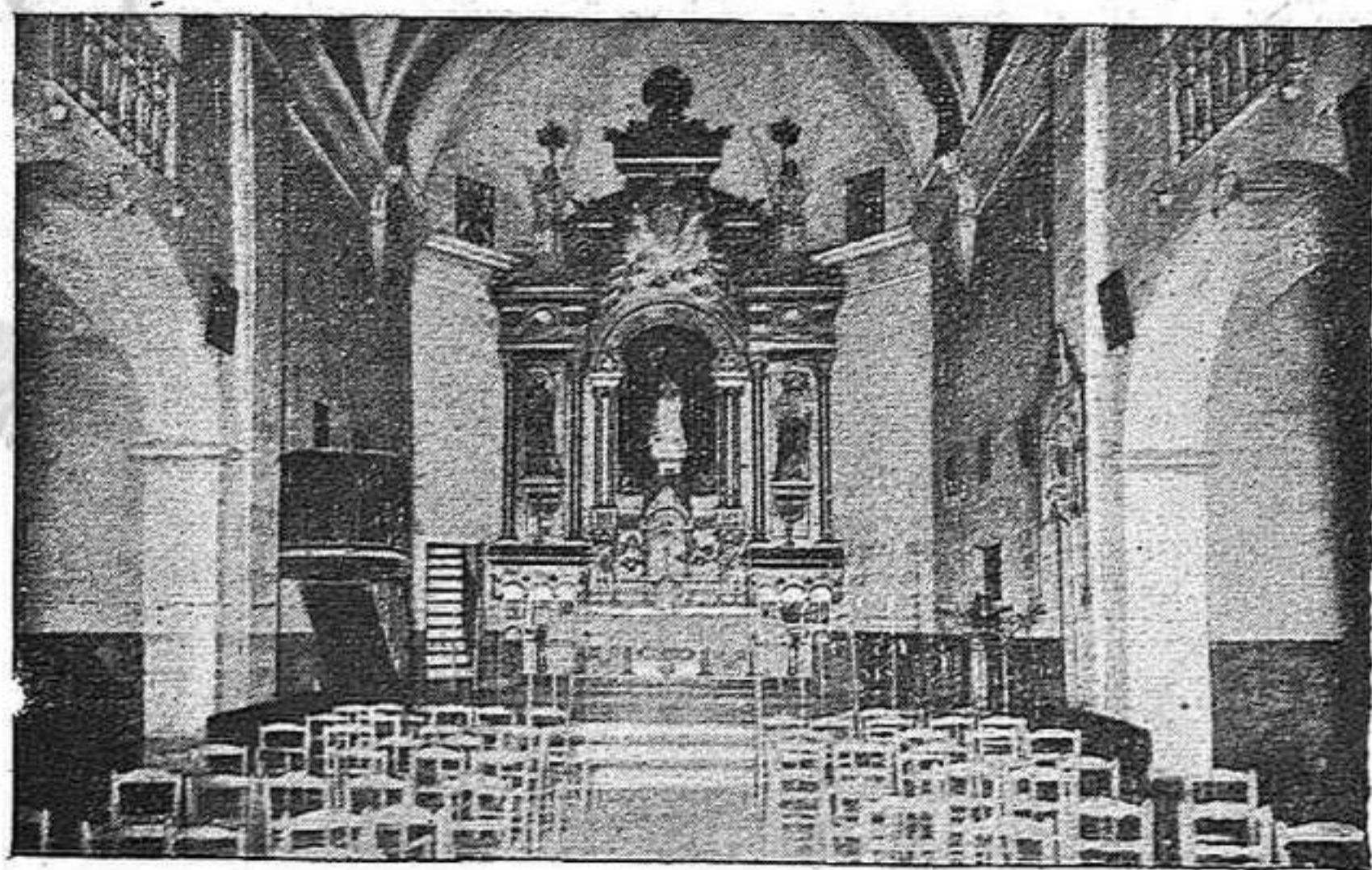
Interior de la iglesia
