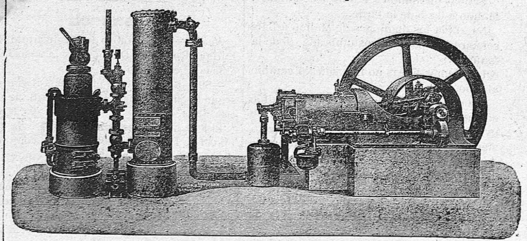
Única casa constructora de los legítimos motores OTTO en combinación con aparatos para gas pobre; sistema por aspiración sin caldera, sin gasómetro.
