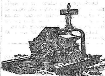
Nuevo aparato perfeccionado para extraer agua, aprovechando los arcañes hasta la última gota del líquido, y con el más pequeño esfuerzo de las caballerías, por la disposición de la artesa y por la suavidad de los rozamientos montados sobre armadura de cilindros.
