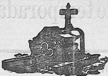
Nuevo aparato perfeccionado para extraer agua, aprovechando los arcauces hasta la última gota del líquido, y con el más pequeño esfuerzo de las caballerías, por la disposición de la arca y por la suavidad de los rozamientos montados sobre armadura de cilindros.
