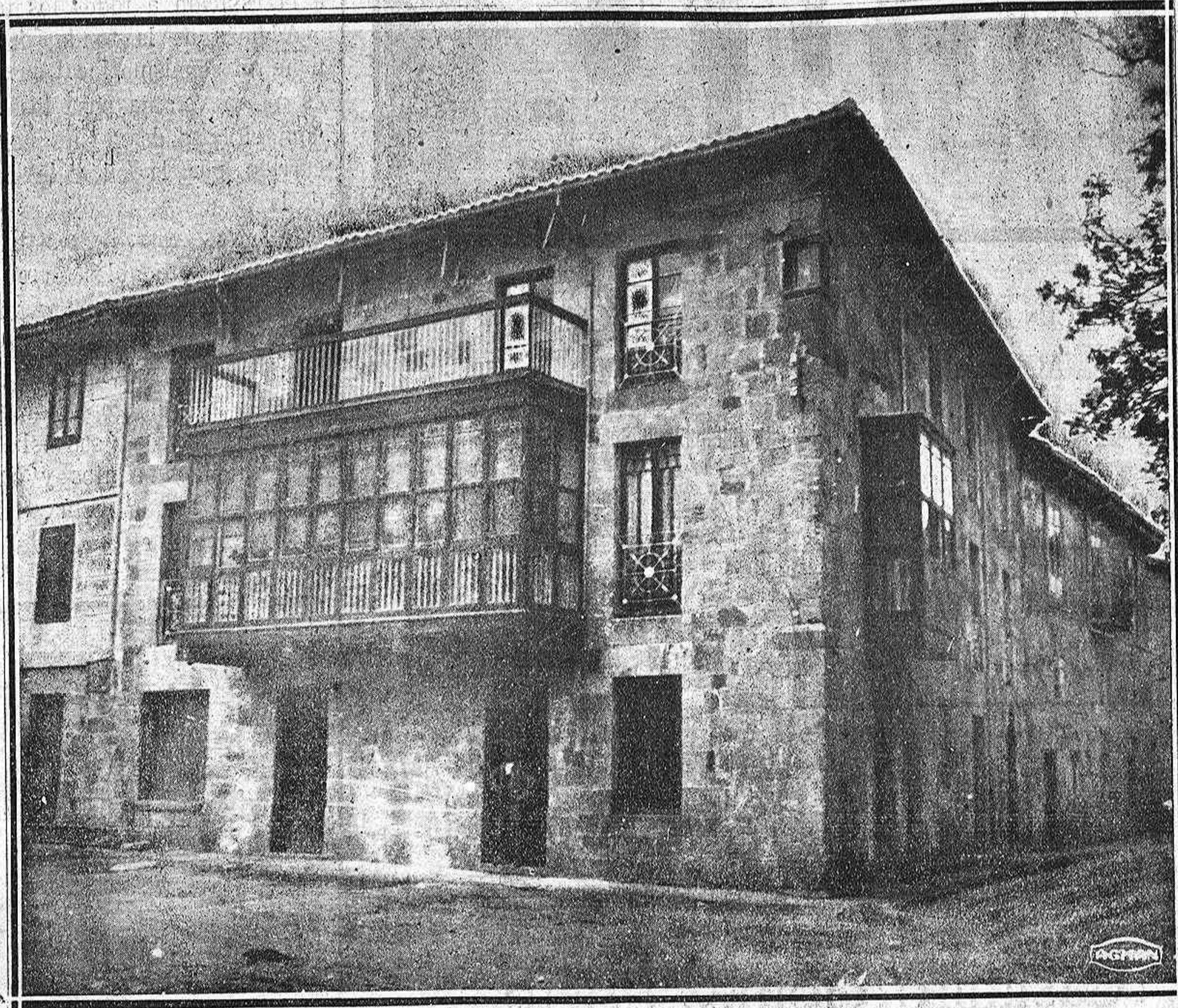
Edificio propiedad de don Manuel Pérez Canales, donde tiene instalados sus almacenes de vinos y materiales de construcción
