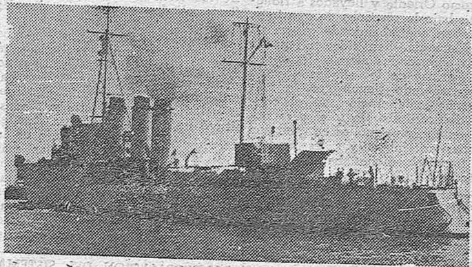
El destructor francés "La Railleuse", terminado de construir en 1927, primero de una serie de trece unidades, desplazaba 1.390 toneladas, media 110 metros de eslora por unos 10 de manga y cuatro de puntal. Estaba armado de cuatro cañones de cinco pulgadas y uno de tres, y de seis tubos lanzatorpedos. Su velocidad era de 39 millas.
